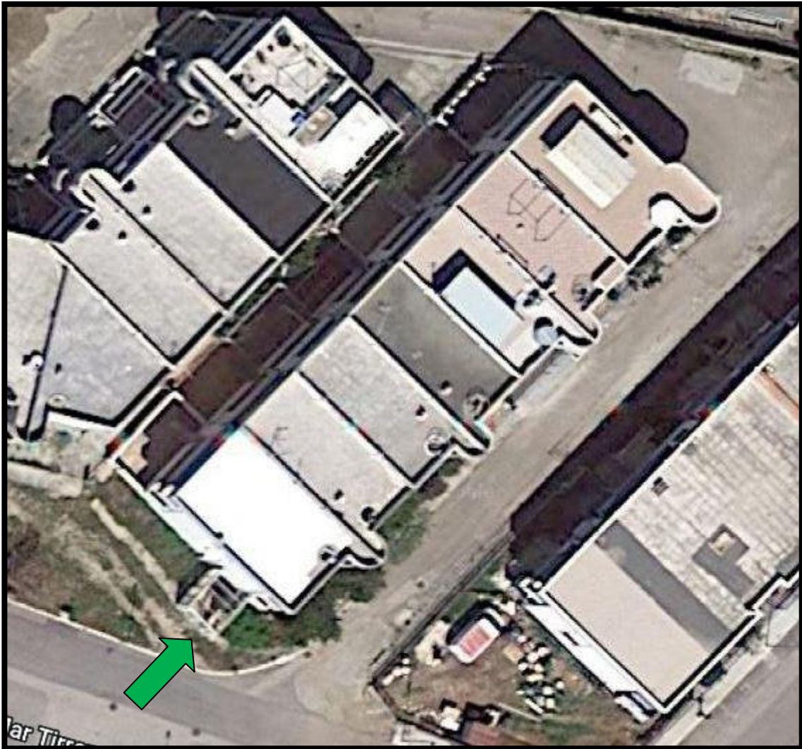
Edificio alla via Mar Tirreno, snc angolo civico 27 in località Marina di Chieuti (FG) con ingresso al magazzino
