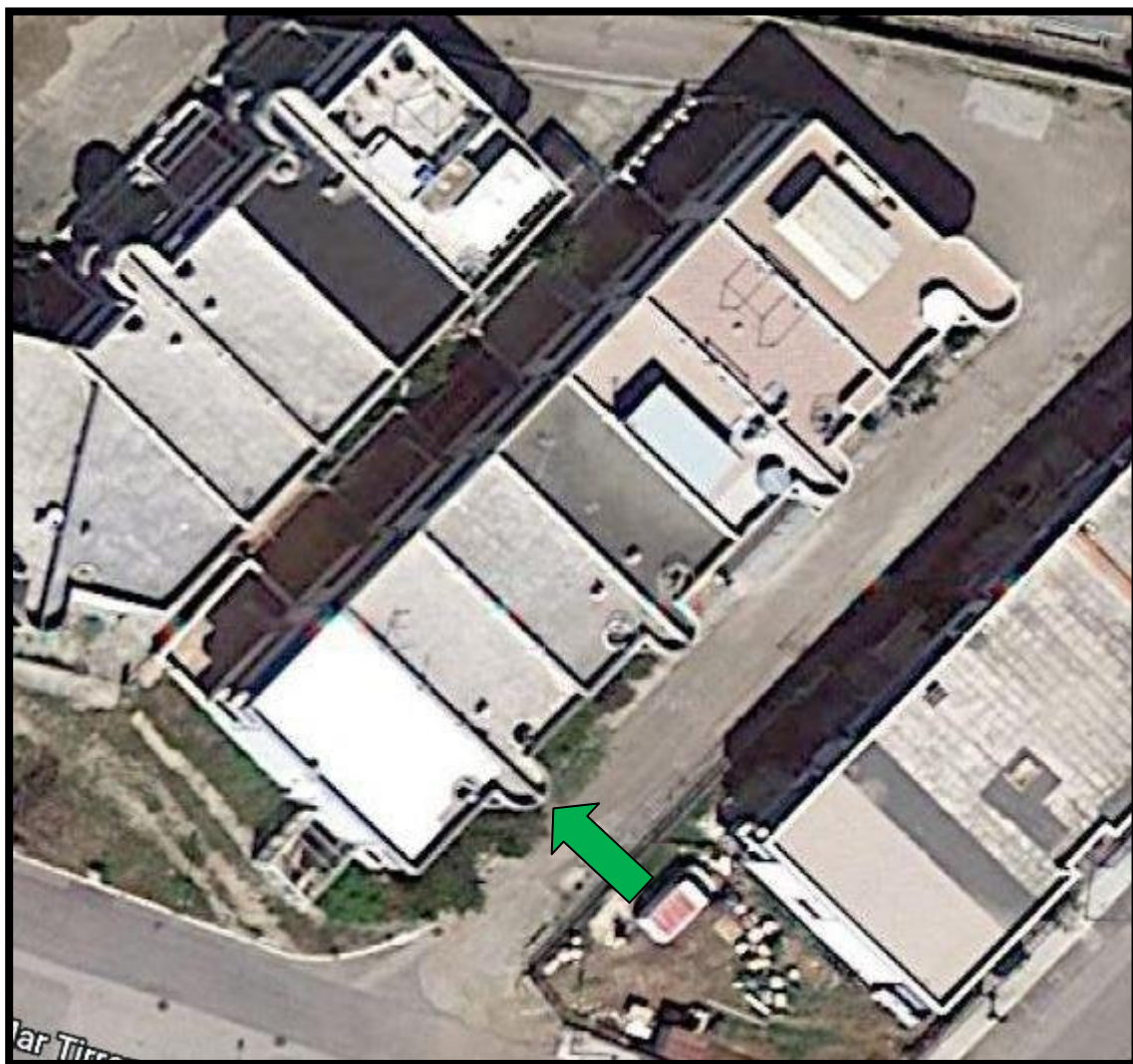
Edificio alla via Mar Tirreno, 27 in località Marina di Chieuti (FG) con ingresso all'appartamento
