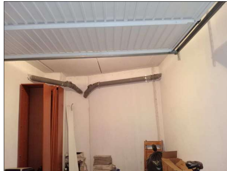
Foto n. 4 - Lotto "2" - Ingresso box-auto n. 5
