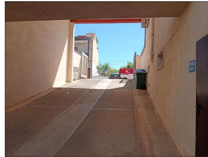
Foto n. 2 - Lotto "2" - Rampa di ingresso al piano interrato
