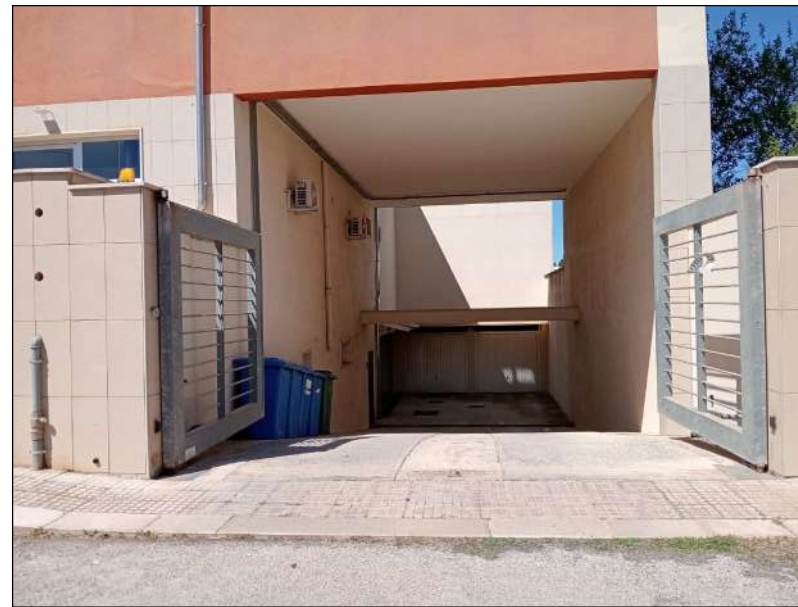
Foto n. 1 - Lotto "2" - Ingresso al piano interrato comune
