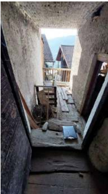
Vano scala a P1
