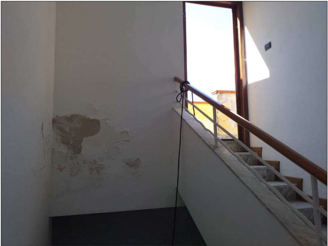
La scala condominiale raggiunge la copertura a lastrico solare
