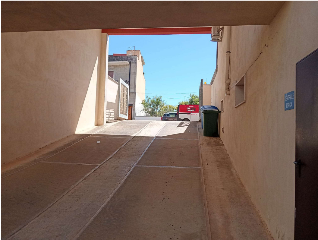
Foto n. 2 – Rampa di accesso ai box auto.
