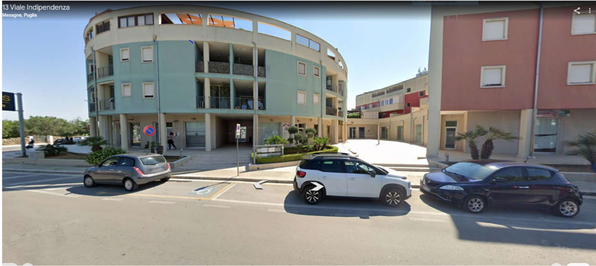
Foto n. 2 – Scorcio del prospetto esterno del condominio – Estrapolazione Google Earth.
