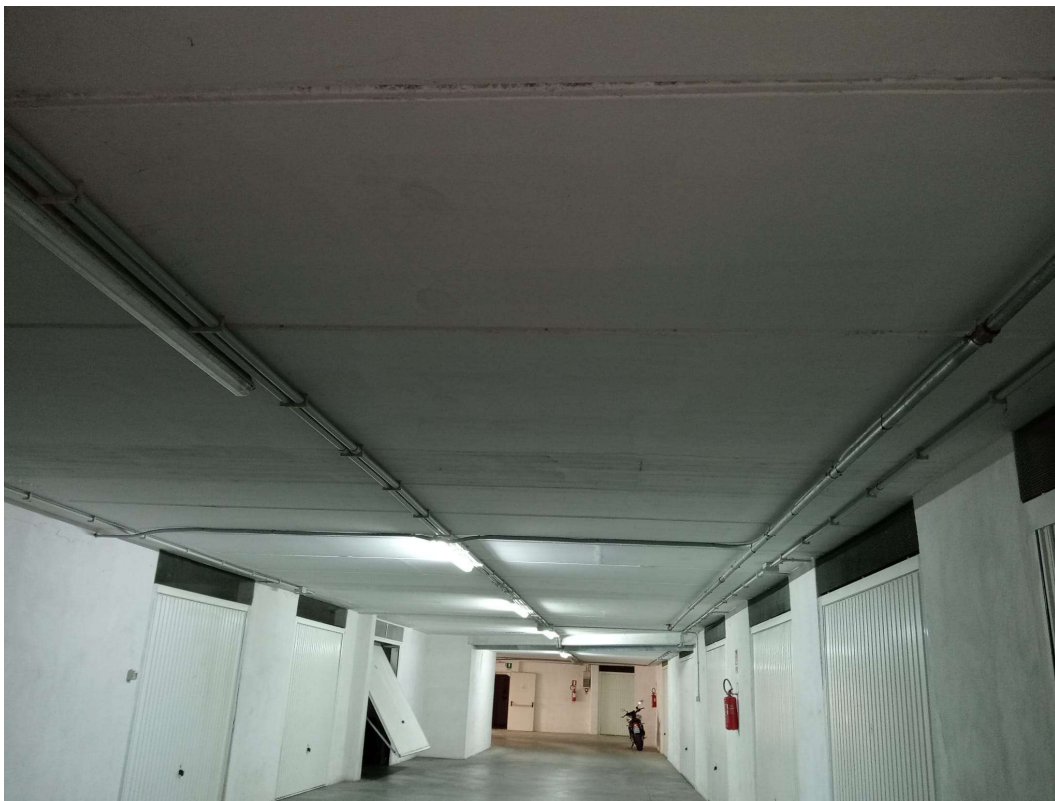
Foto n. 3 – Area comune di manovra ai box auto.
