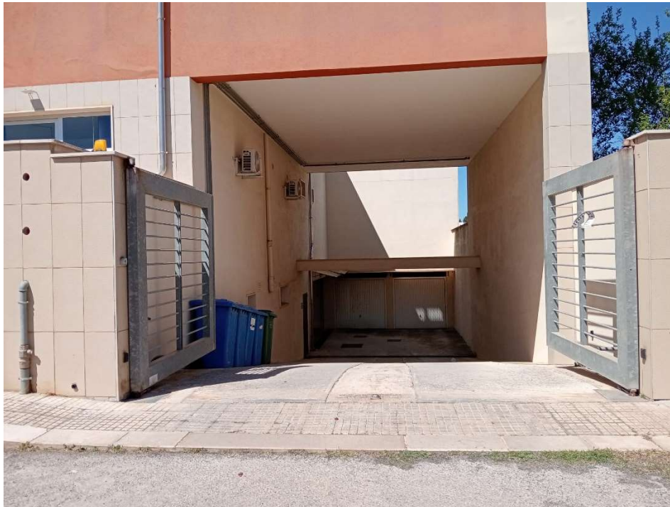
Foto n. 1 – Ingresso alla rampa comune.
