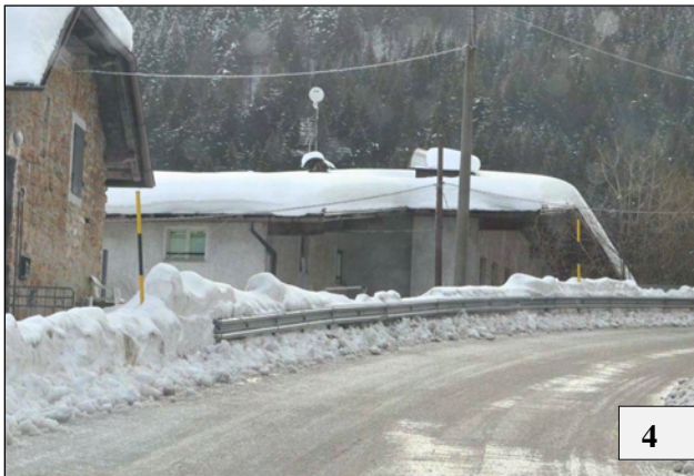
VISTA SUL LATO NORD OVEST DALLA STRADA
