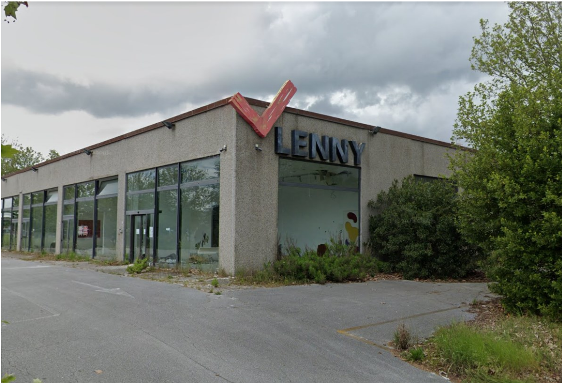
Fotografia n. 1 – vista da fronte / fianco destro
