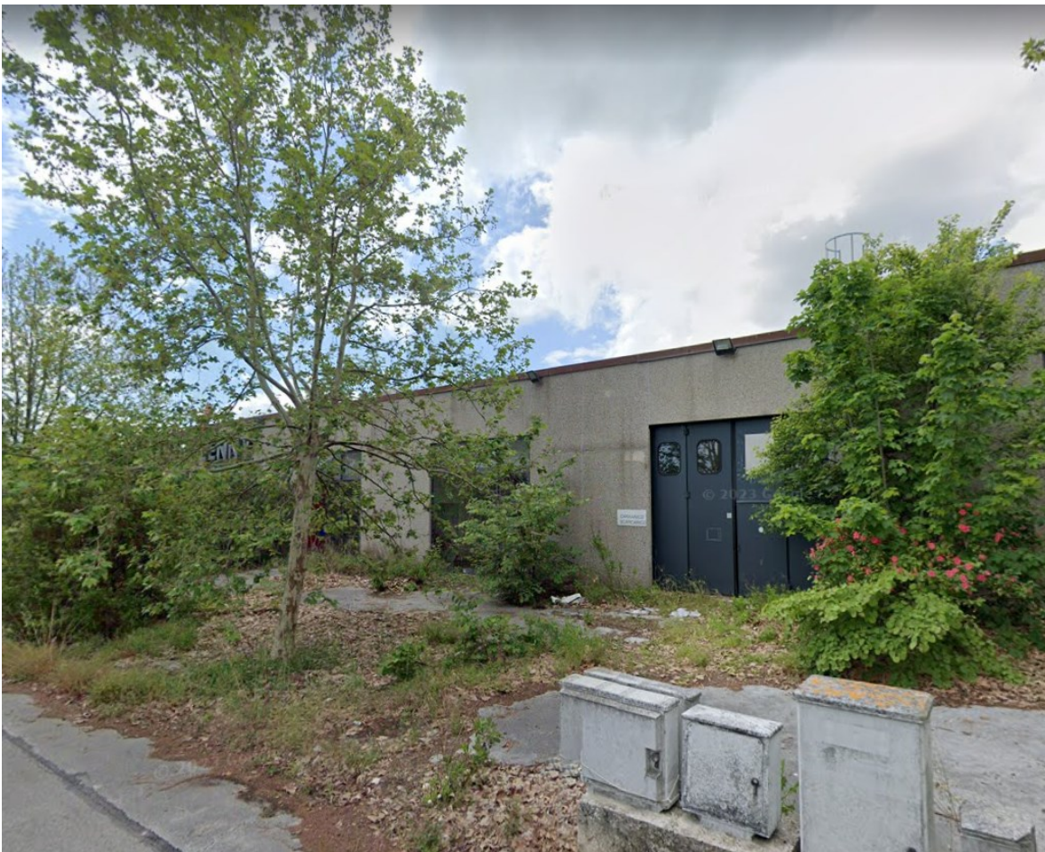
Fotografia n. 2 – vista fianco destro
