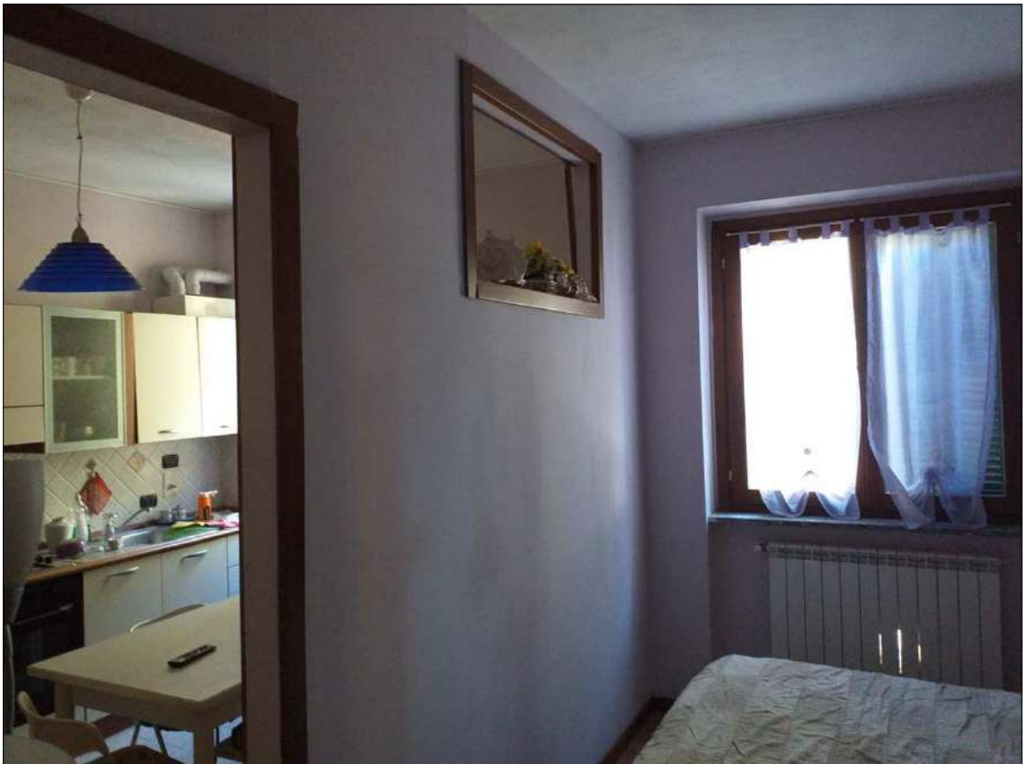
La parete da demolire tra l'ingresso/camera e la cucina
