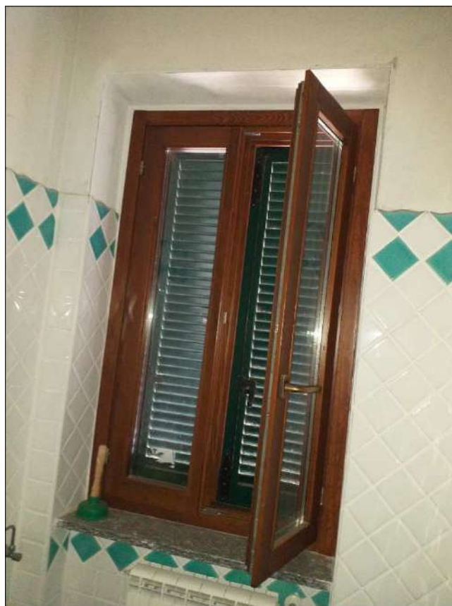
La finestra del bagno
