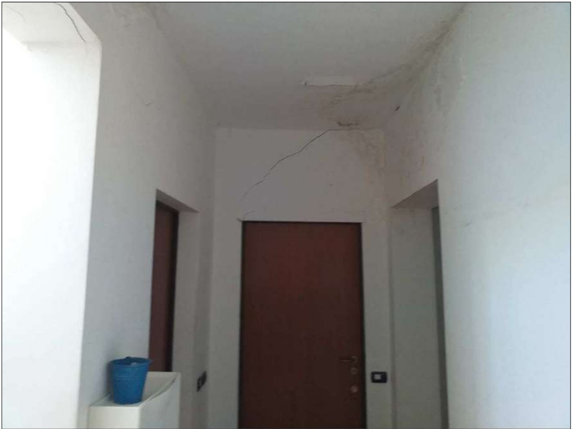
Il pianerottolo del secondo piano, a dx il portoncino dell'alloggio sub 12
