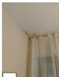
Foto n. 20 - Camera n.1 - soffitto
