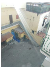
Foto n. 3 - Secondo cortile e rampa scala esterna di accesso al vano scala
