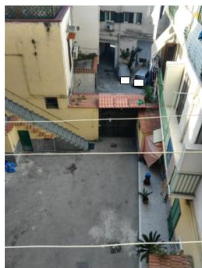
Foto n. 4 - Secondo cortile e rampa scala esterna di accesso al vano scala
