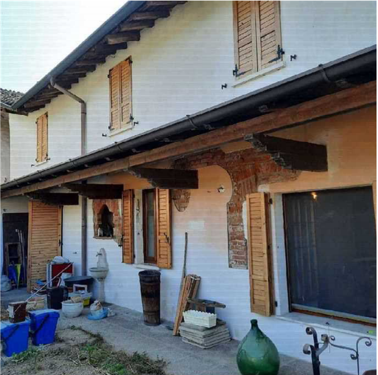
Foto 6 Fg. 7 mapp. 426 sub. 1 e 2 fronte interno
