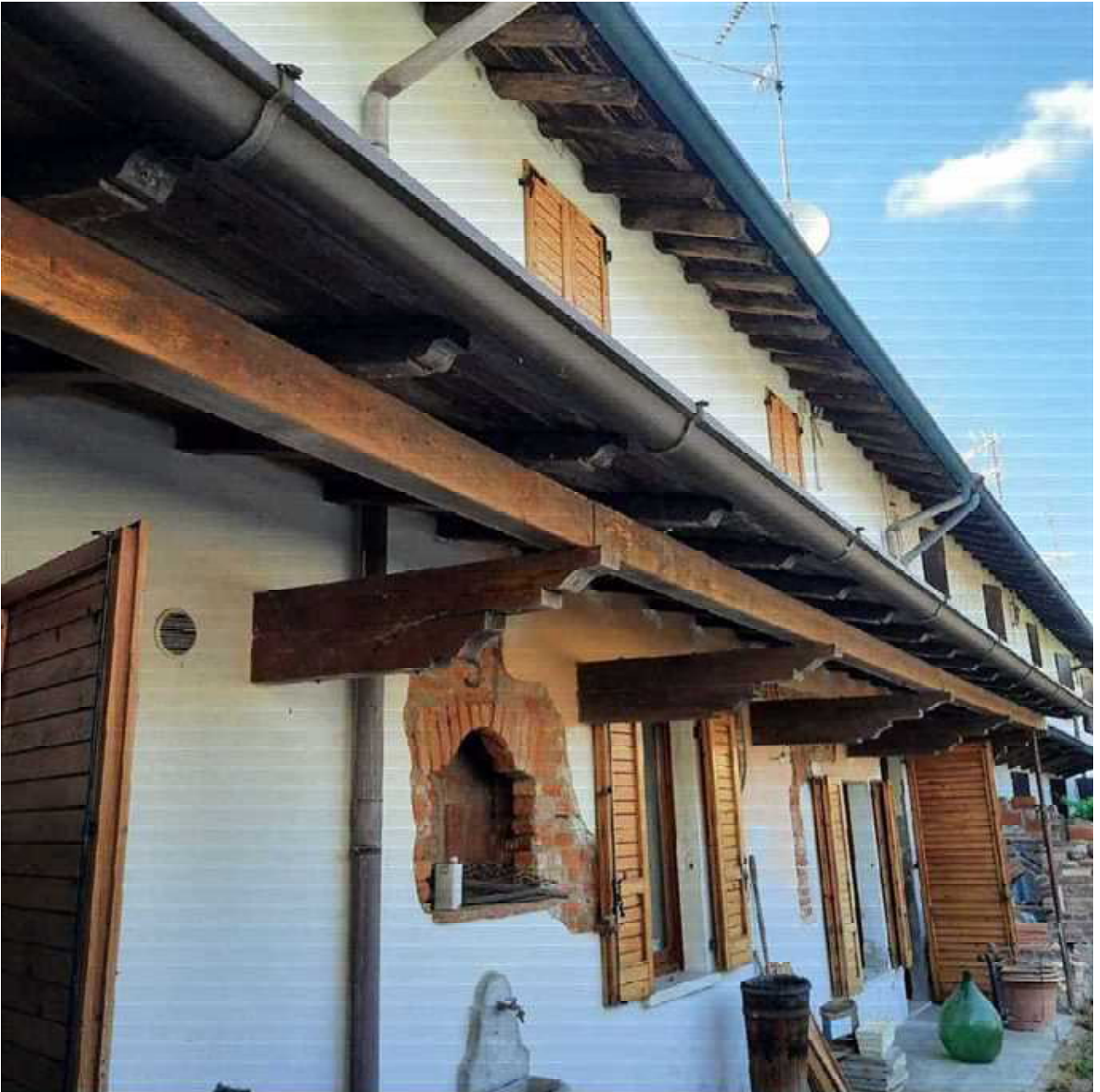
Foto 5 Fig. 7 mapp. 426 sub. 1 e 2 fronte interno
