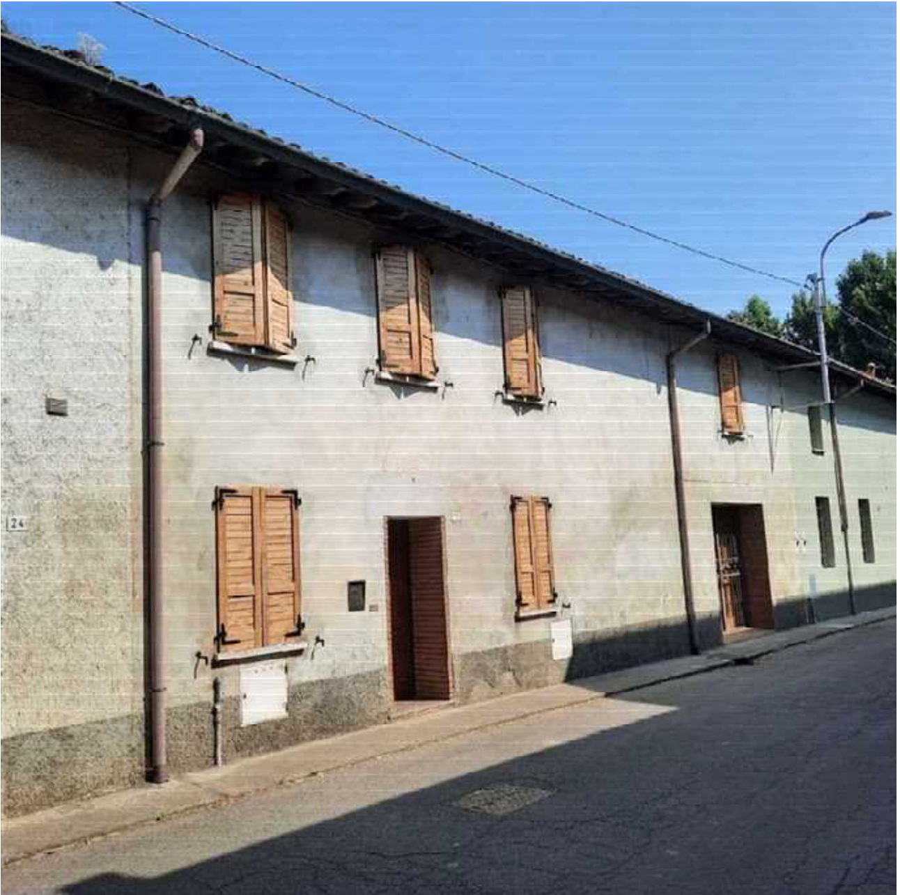
Foto 3 Fig. 7 mapp. 426 sub. 1 e 2 fronte Via XXV Aprile, 20 e 22
