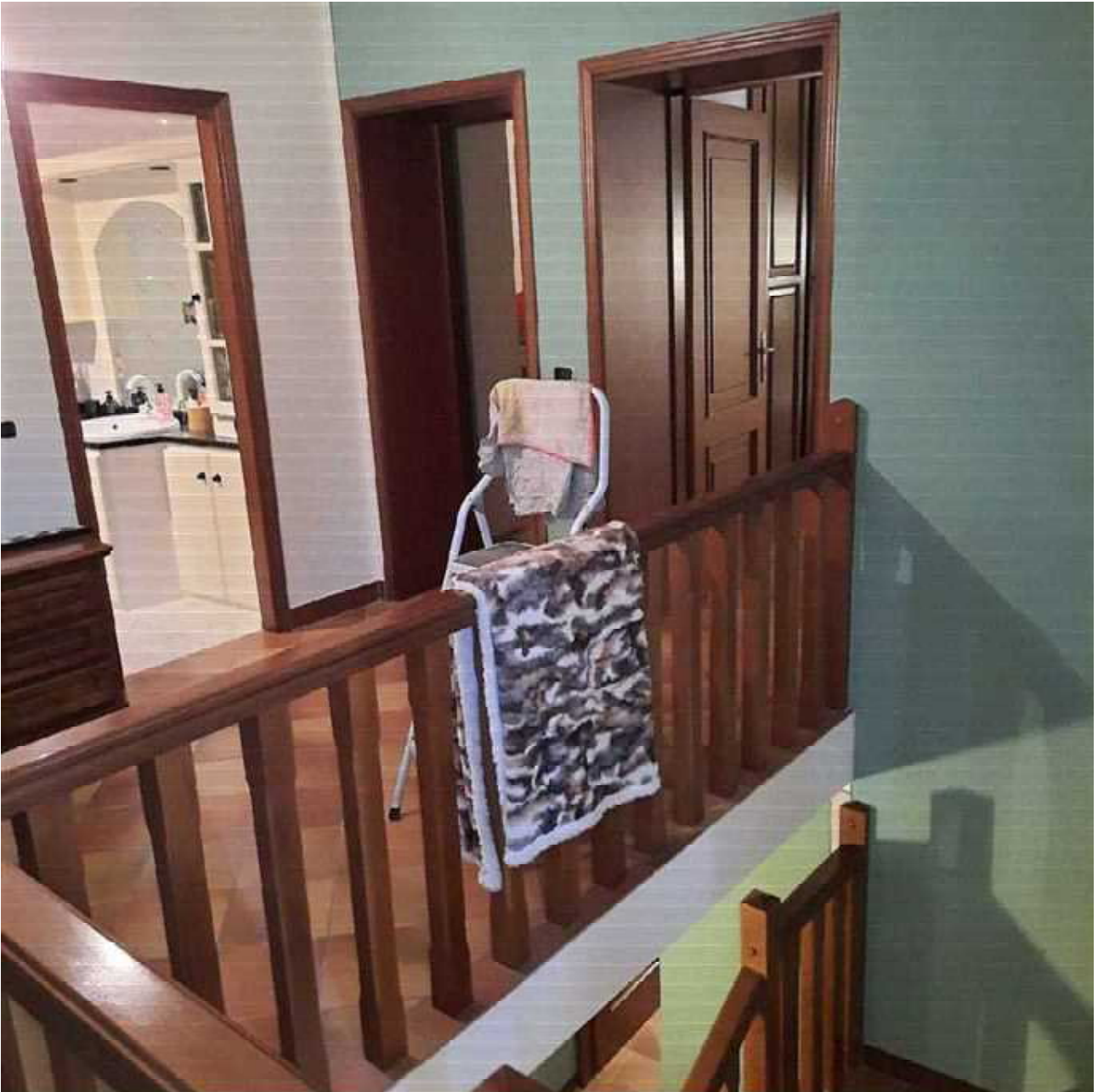
Foto 16 Fg. 7 mapp. 426 sub. 1 Disimpegno piano primo
