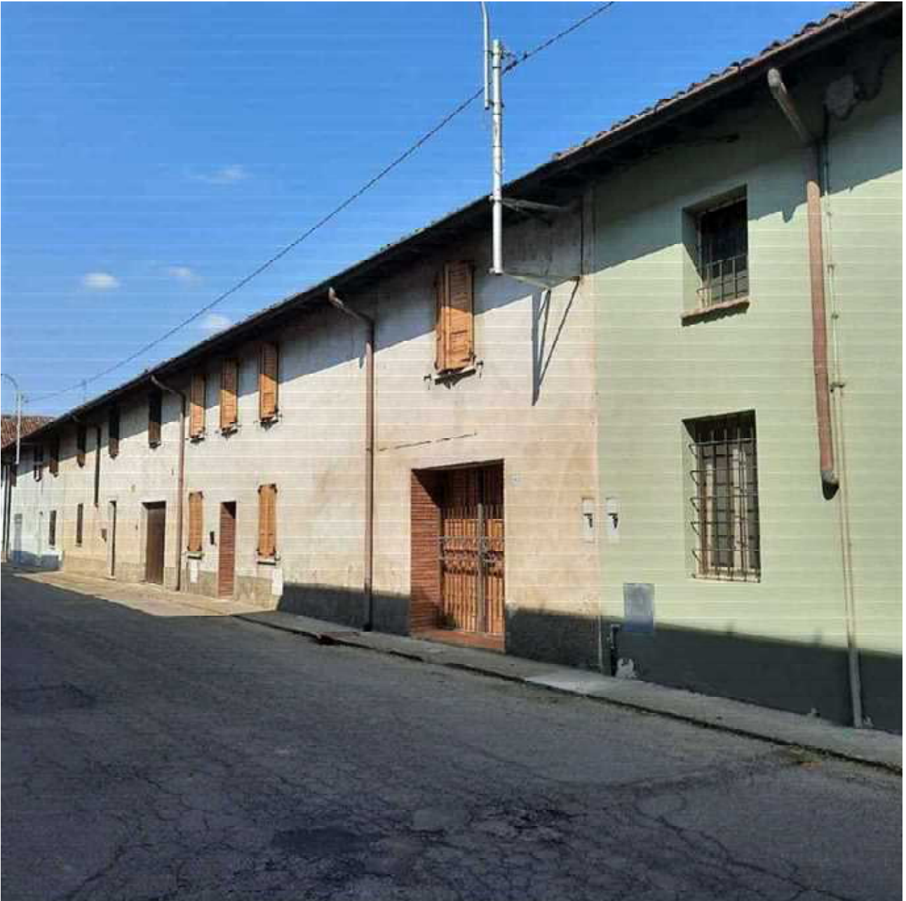
Foto 4 Fig. 7 mapp. 426 sub. 1 e 2 fronte Via XXV Aprile, 20 e 22
