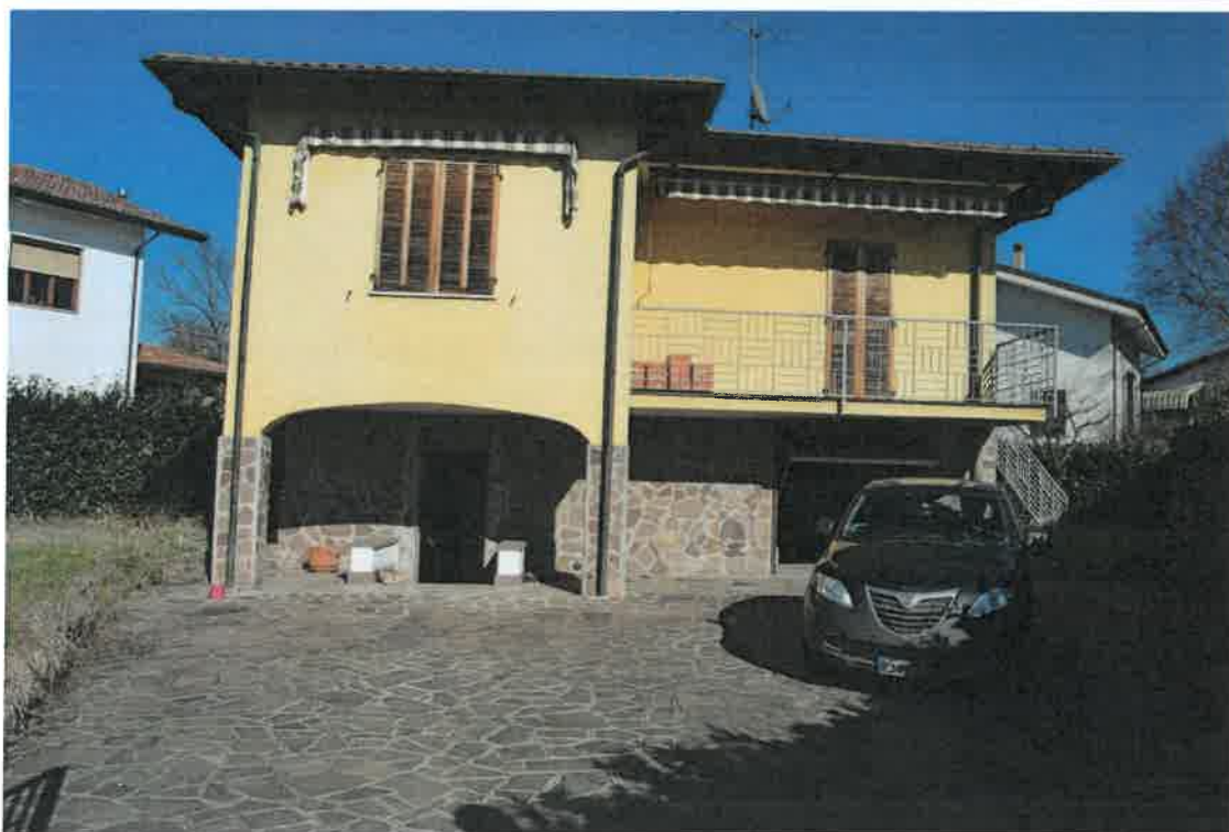
LOTTO 2 FABBRICATO UNIFAMILIARE VALMADONNA – Facciate esterne foto 18-19)
