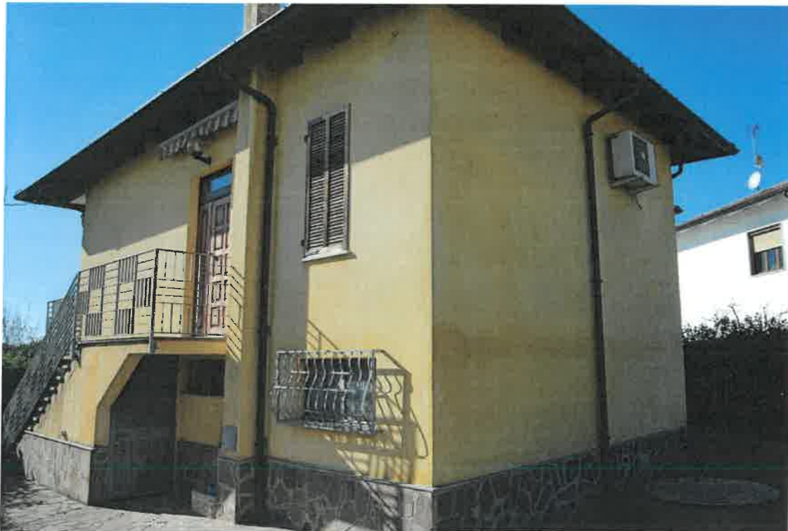
LOTTO 2 FABBRICATO UNIFAMILIARE VALMADONNA – Facciate esterne foto 20-21)
