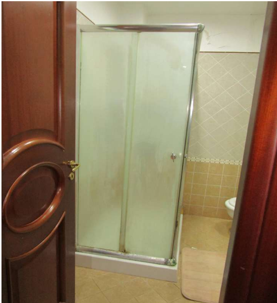
Foto 12 – bagno 2 (box doccia)
