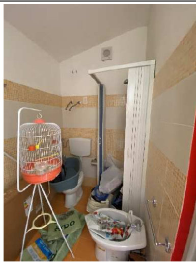
Piano primo villa – wc 5
