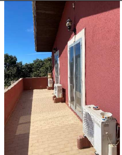
Piano primo villa – balcone
