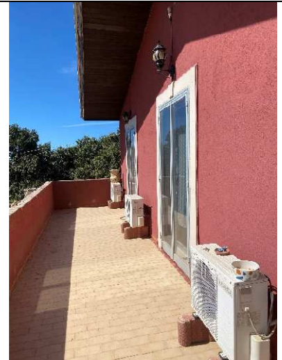
Piano primo villa – balcone
