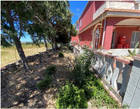
Giardino (lato sud)
