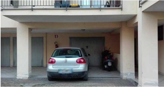
FOTO 27/327 - Vista posto auto coperto
