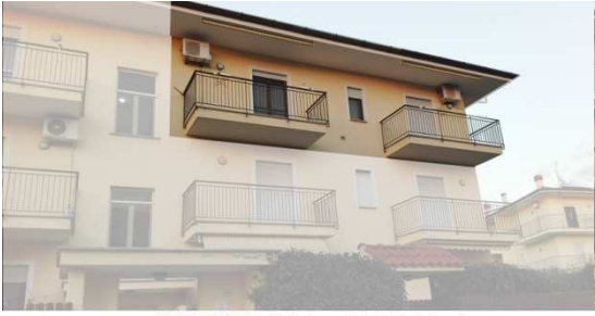
FOTO 17/458 - Vista immobile da Sud-Ovest
