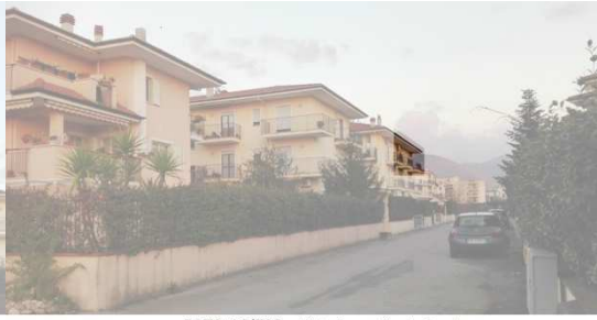
FOTO 16/723 - Vista immobile da Ovest
