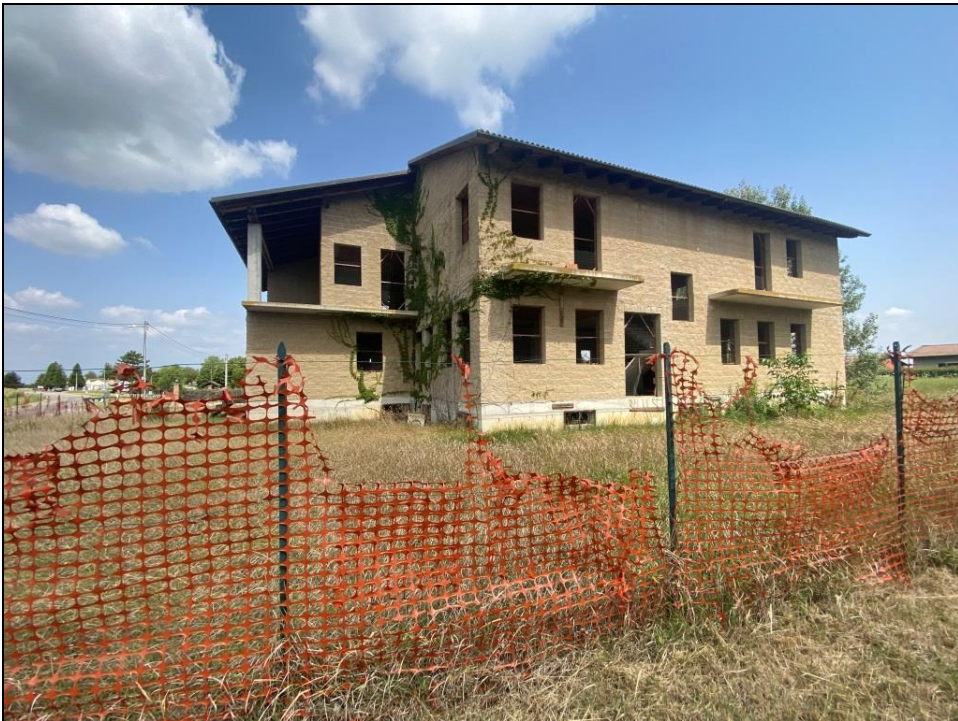
Immagine 6: Prospetto lato Sud Ovest
