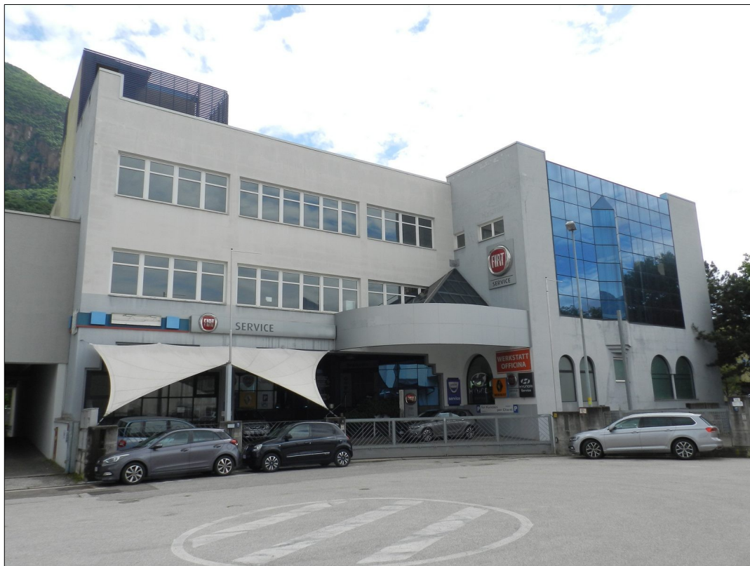
Vista prospettica da via Kravogl dell'edificio p.ed. 3295 C.C. Dodiciville
