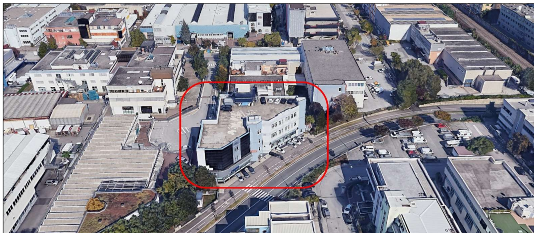
Vista prospettica e aerea di via Einstein e via Kravogl che circoscrivono l'edificio p.ed. 3295 C.C. Dodiciville
