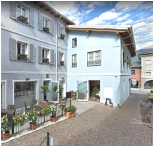
vista porzione fabbricato ingresso ristorante
