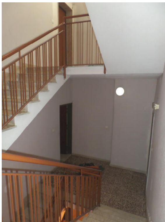
Foto n° 5. Vano Scala – Piano 2°
