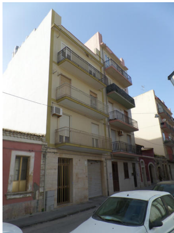
Foto n° 3. Via Epicarmo – Vista Sud
