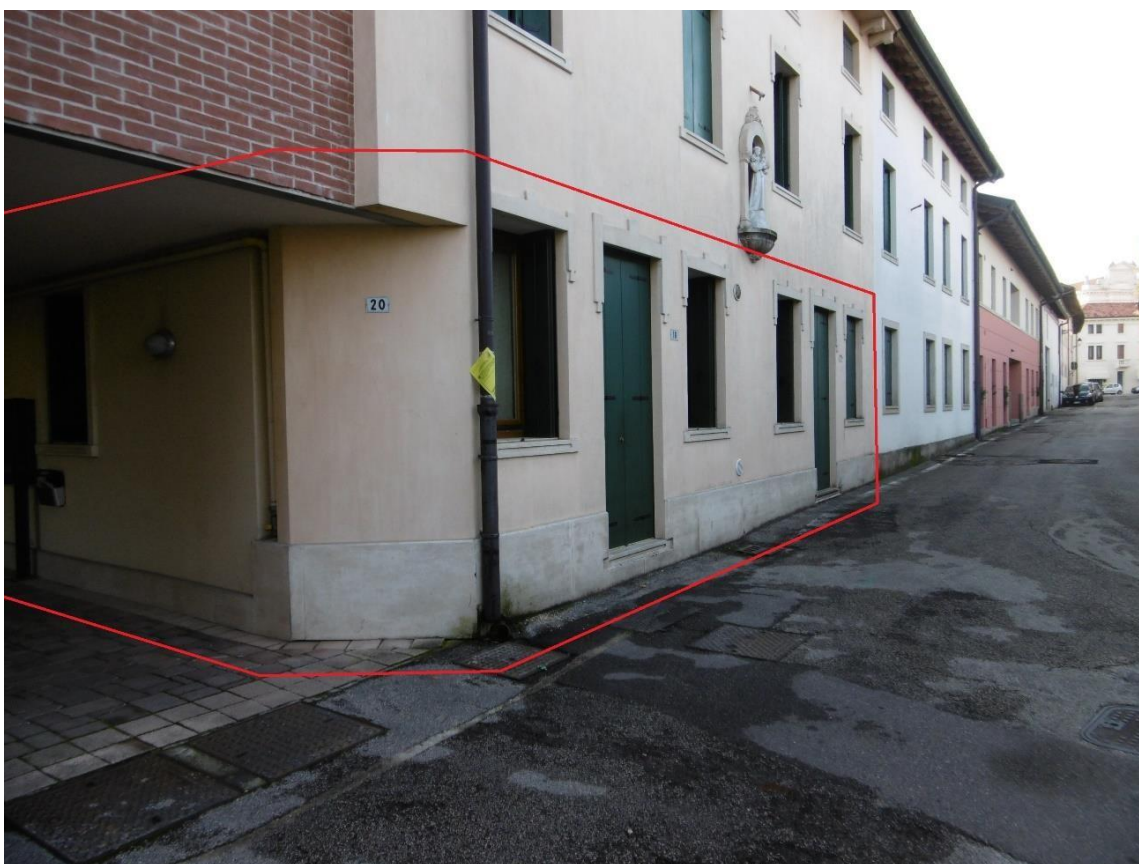
Prospetto principale con individuazione dell'immobile oggetto di perizia da via Brega – lato nord
