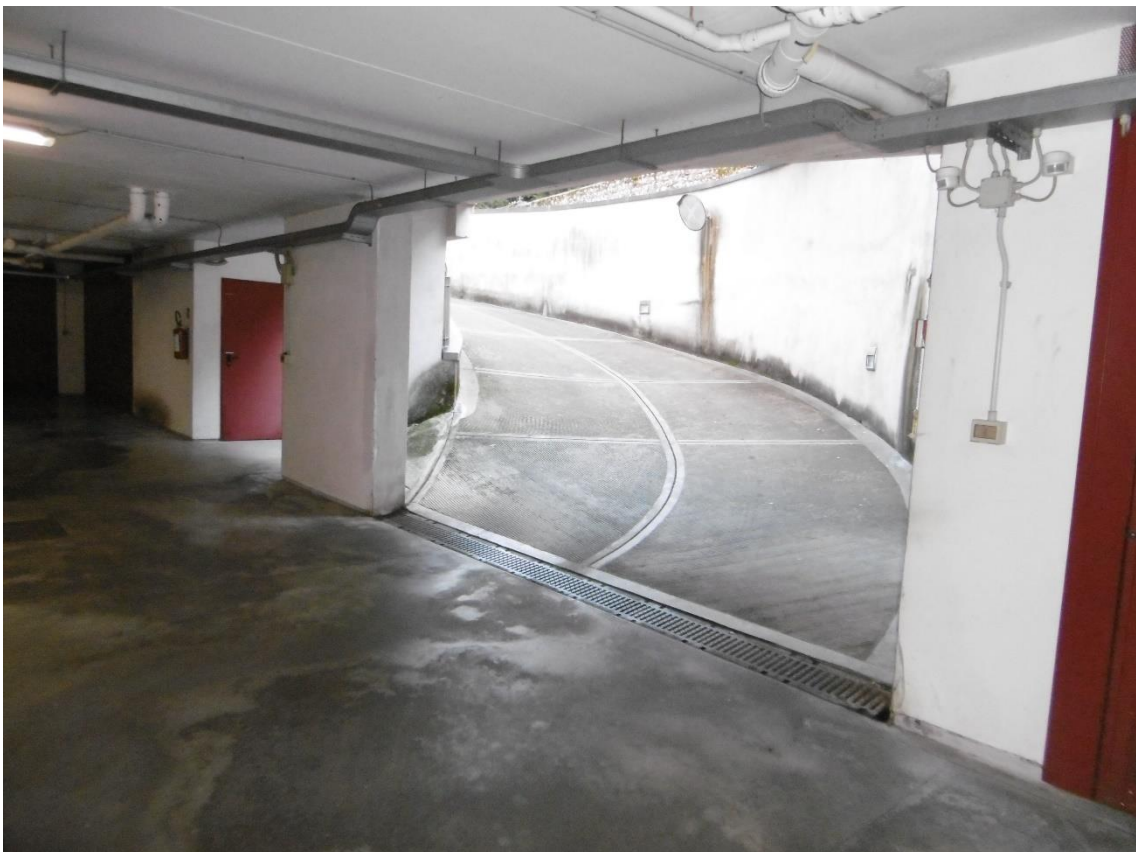
Corsie di accesso al garage (parti comuni)
