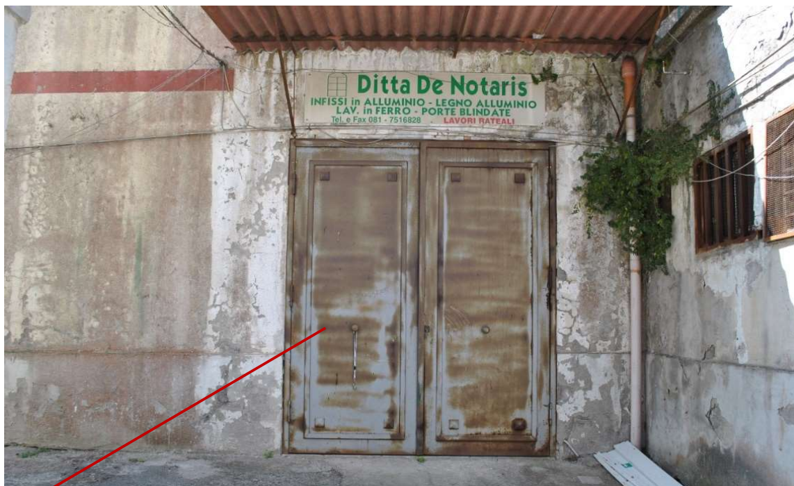
Accesso al deposito
