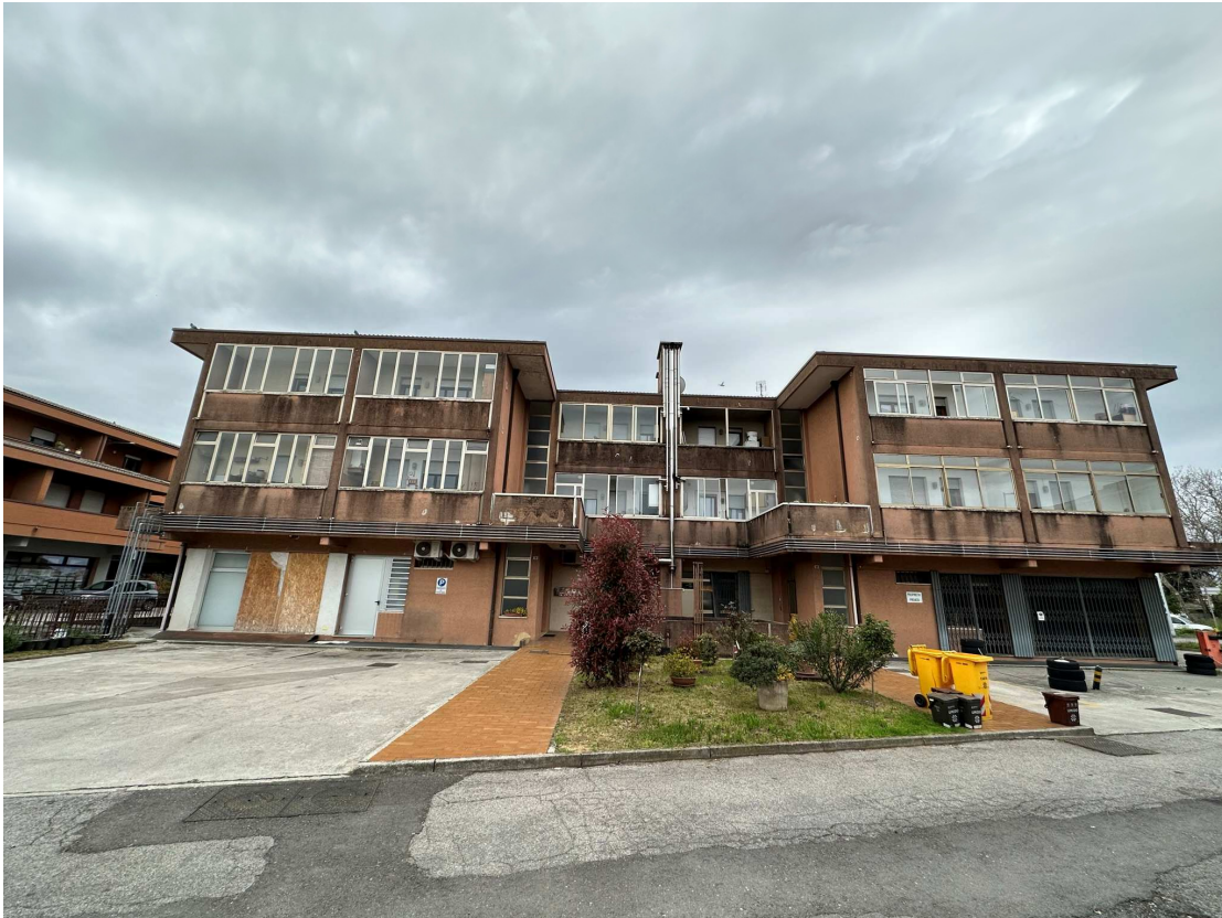
Lato nord - ingresso
