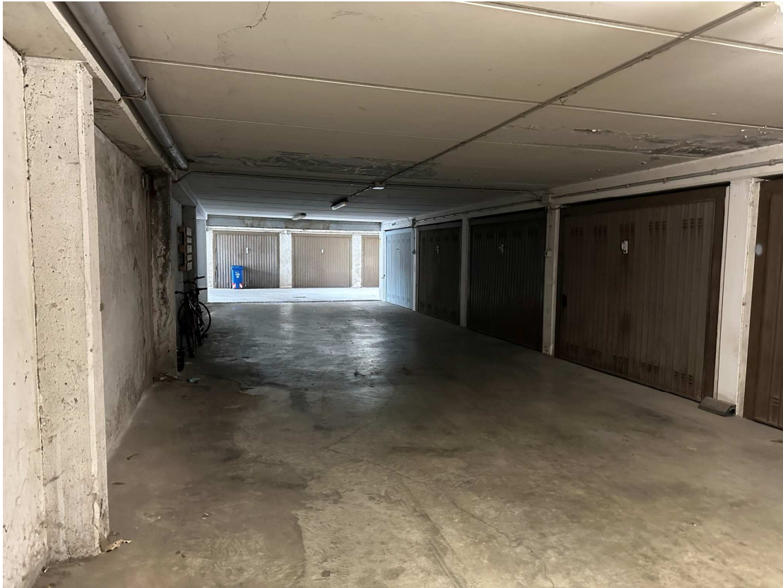
Piano interrato - area di manovra
