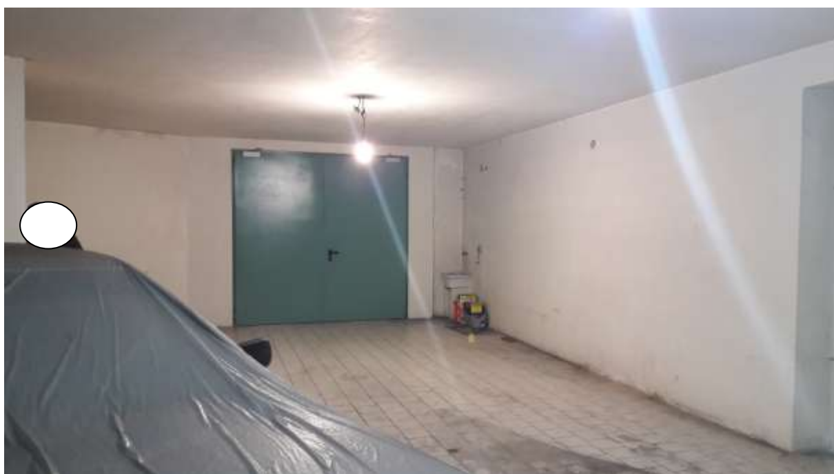
Foto 6 – Vista interna opposta all'ingresso 1
