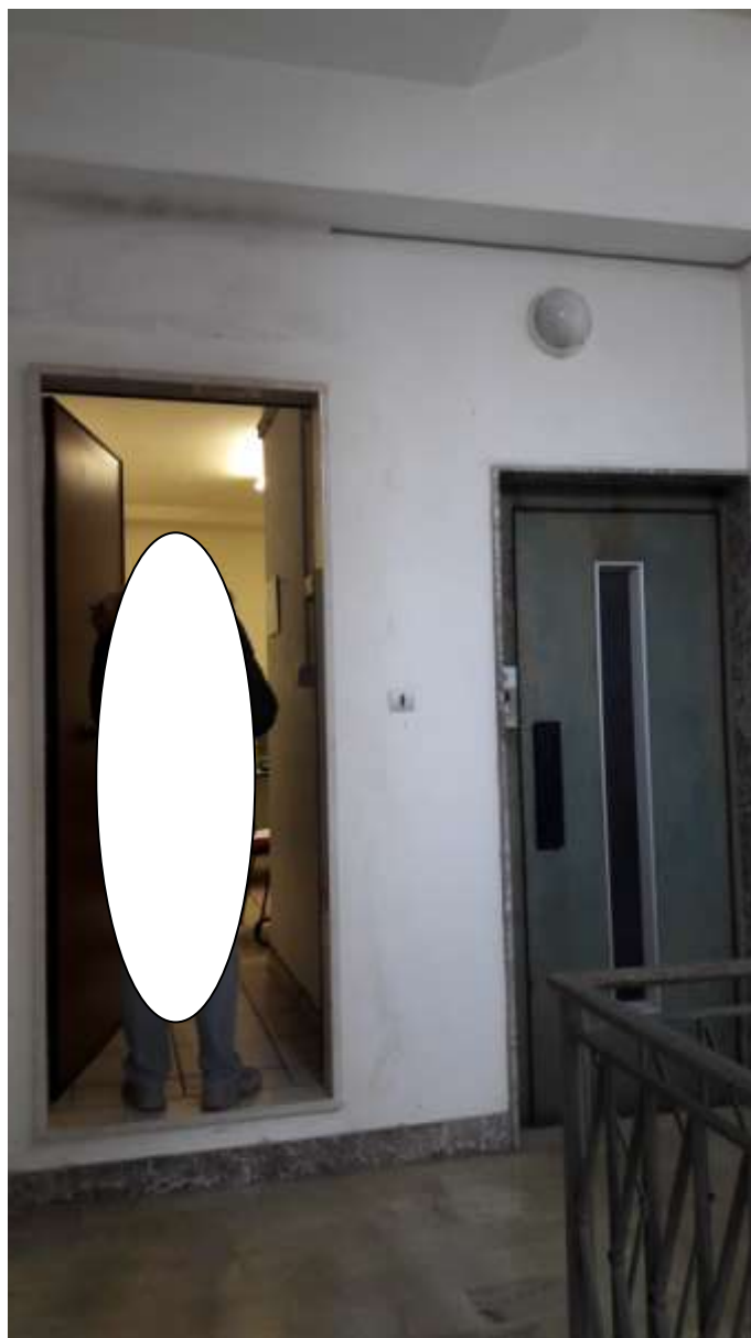
Foto 14 – Vista porta d’ingresso soppalco dal vano scala condominiale
