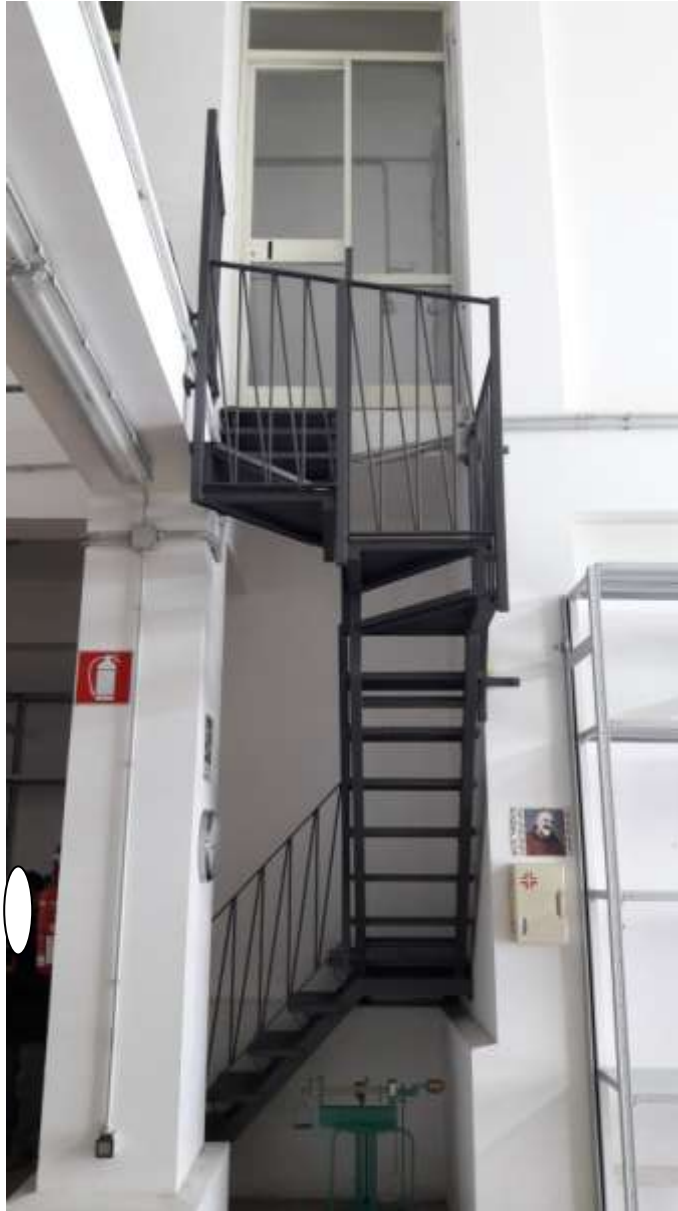
Foto 13 – Vista scala in acciaio con porta ingresso soppalco
