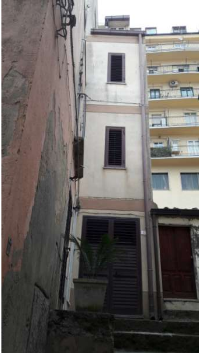
Foto 3 – Vista Nord, ingresso via Savoca n.21
