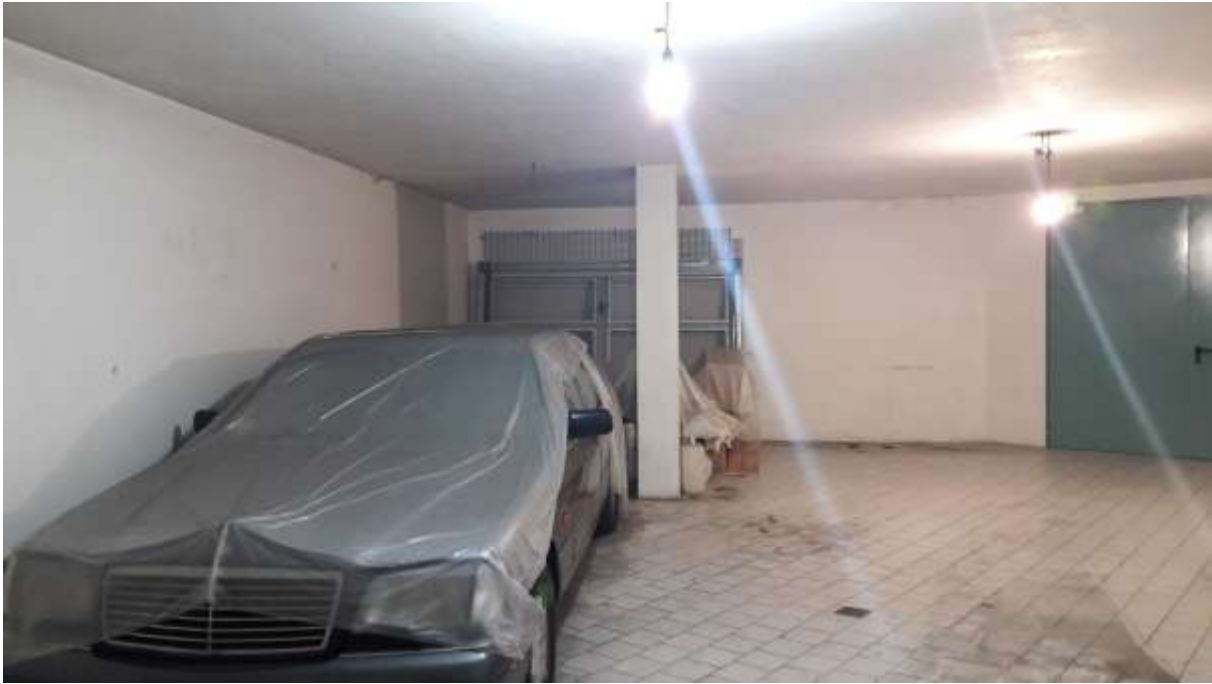
Foto 7 – Vista interna opposta all'ingresso 2
