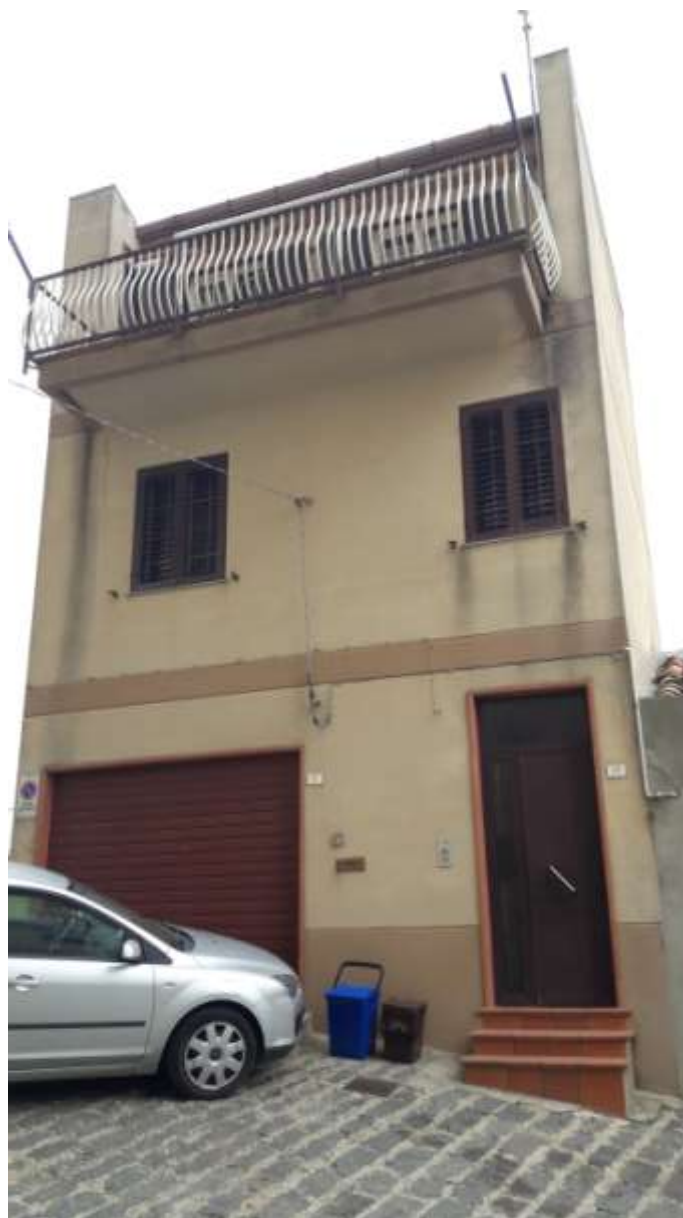
Foto 4 – Prospetto Sud, ingresso principale via Atene n. 19 e n. 17
