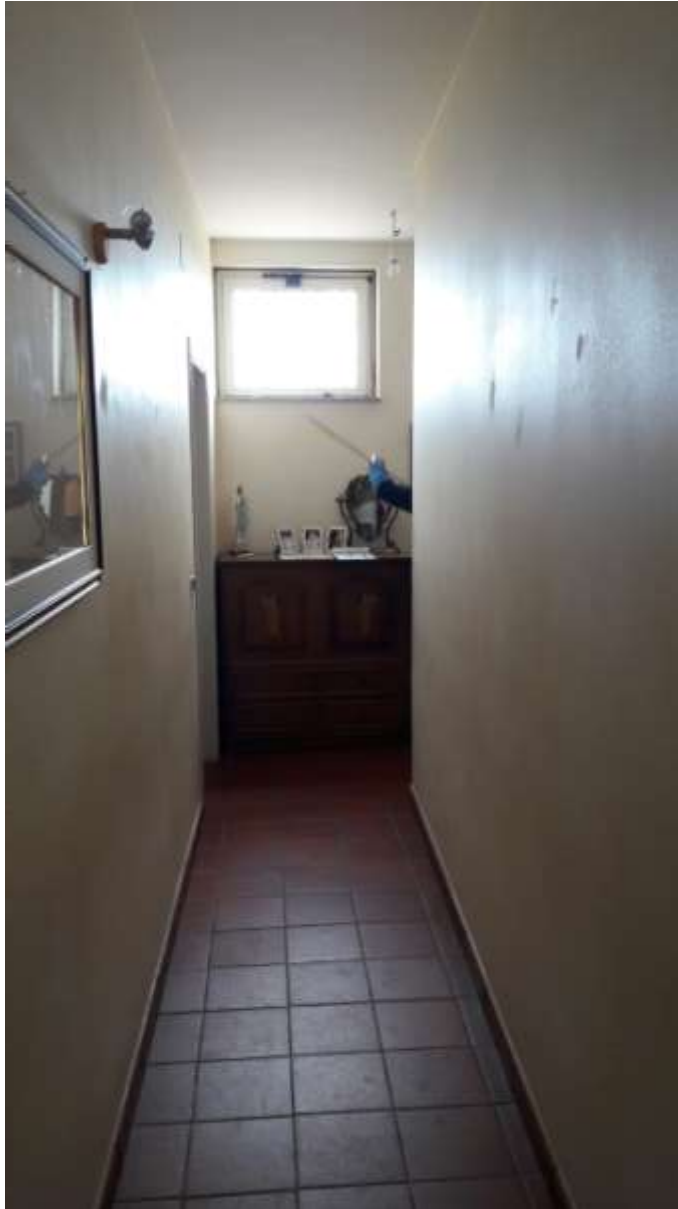
Foto 21 – Vista disimpegno del primo piano dal lato Sud
