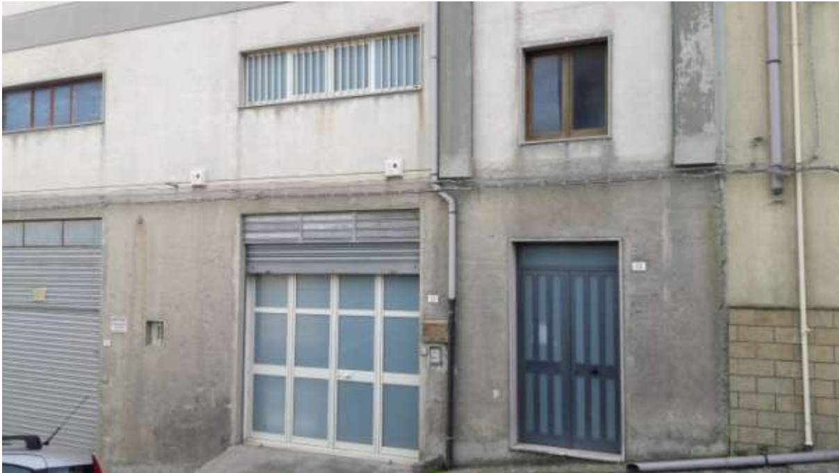
Foto 2 – Ingressi via Atene nn. 54 e 52
