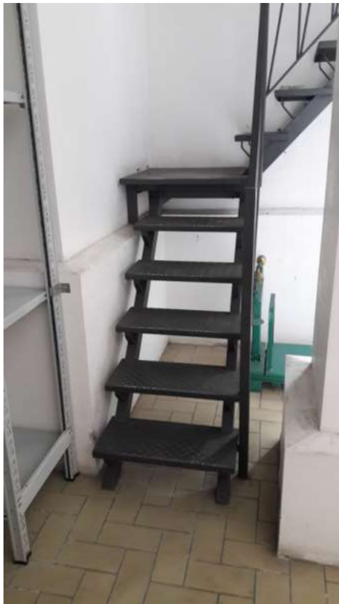
Foto 12 – Vista frontale della scala in acciaio
