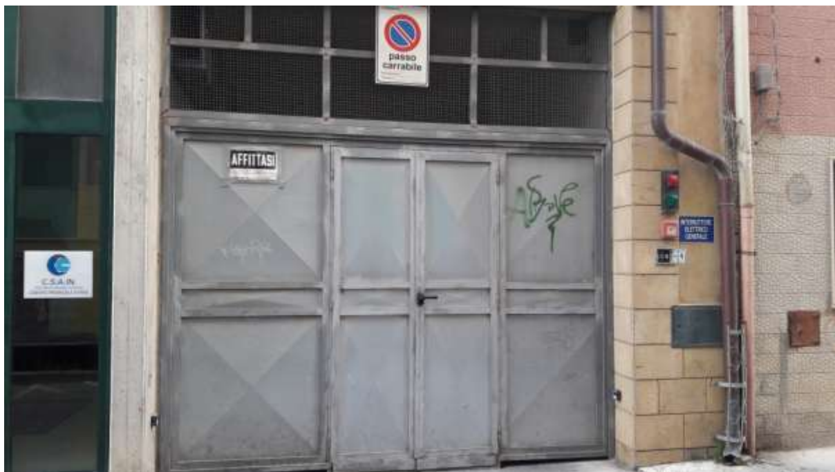
Foto 1 – Ingresso principale condominiale via Archimede
