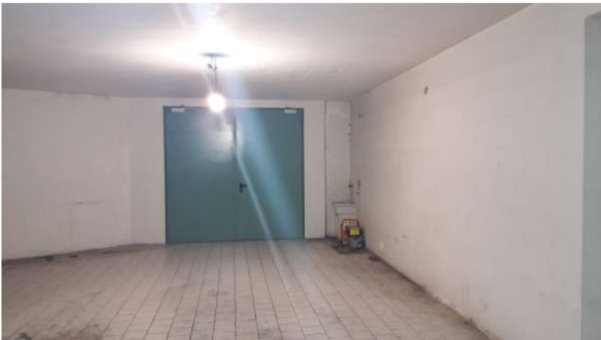
Foto 8 – Vista interna opposta all'ingresso 3
