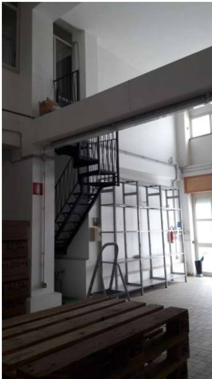
Foto 7 – Vista posizione scala in acciaio
