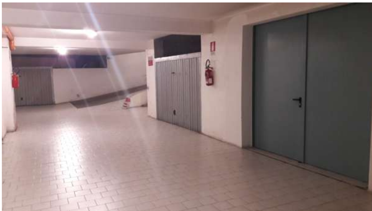
Foto 2 – Vista della rampa e dello spazio di manovra condominiale
