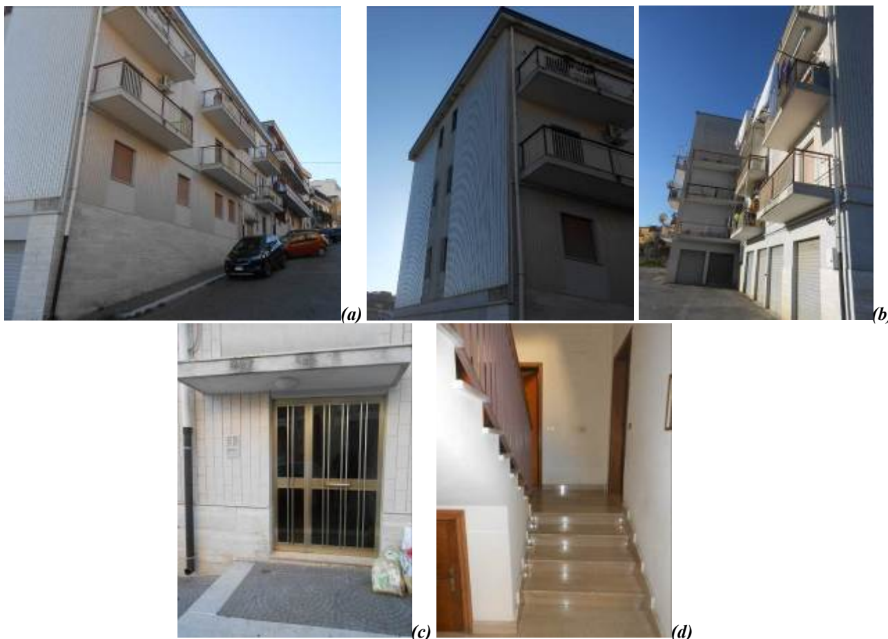
Figura n° 2. Fotografie del fabbricato condominiale: prospetto su via Fontane (a); prospetti su strada privata (b); portone condominiale (c); scalinata condominiale (d).
