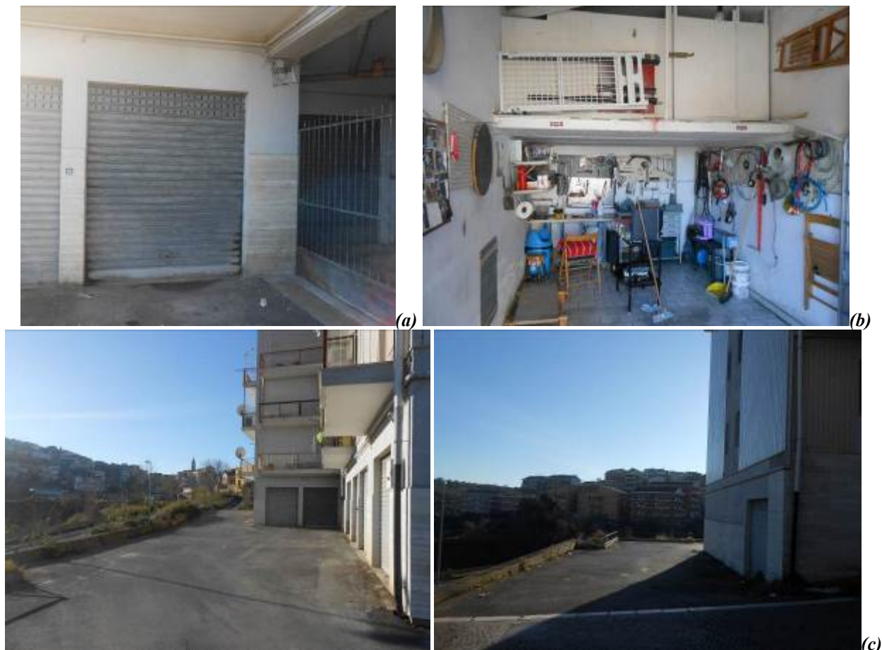
Figura n° 6. Fotografie del locale box a pianterreno ubicato in via Fontane senza numero civico: serranda di accesso (a); ambiente interno (b); strada privata (c).
