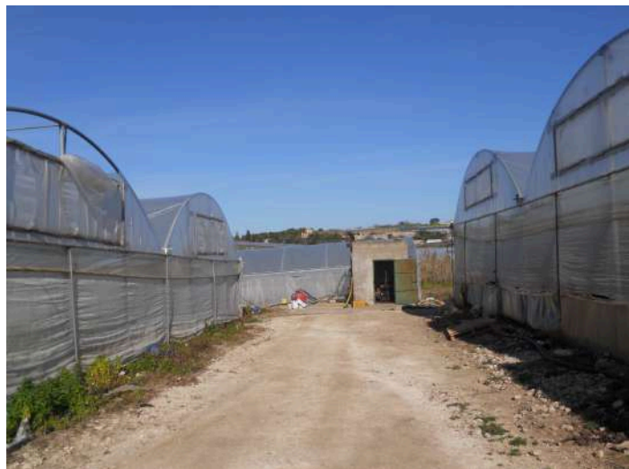
SERRE PRESENTI NELLA P.LLA 191 CON POZZO
