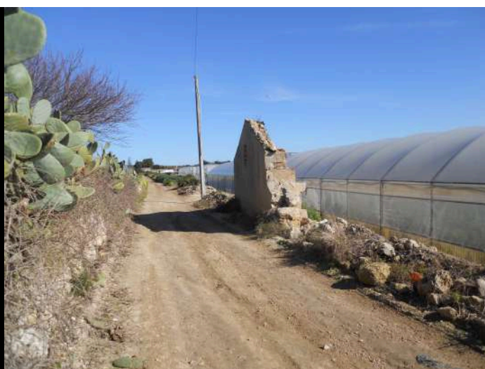
CONFINE OVEST DELLA P.LLA 42
