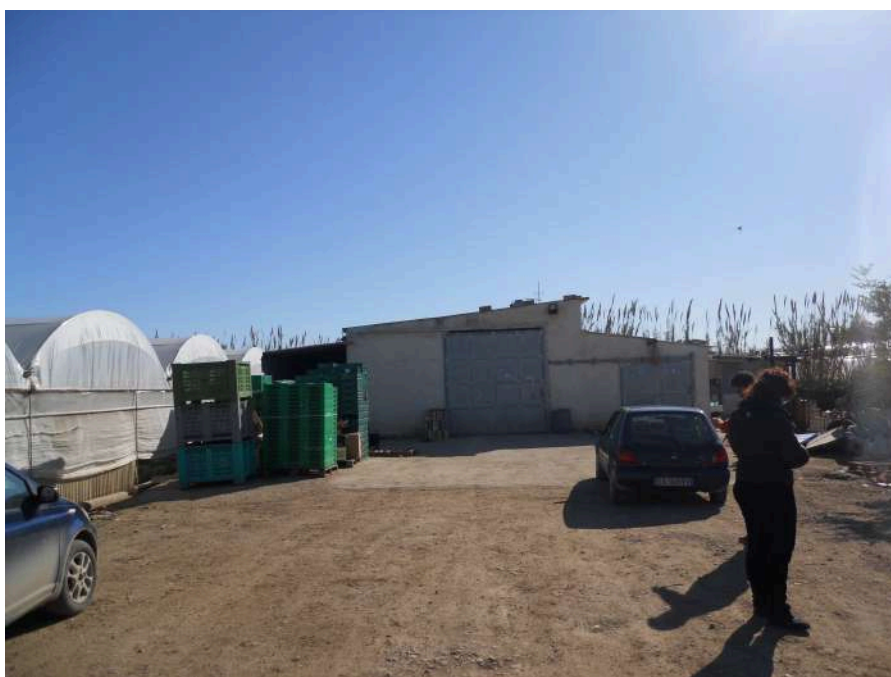
IMMOBILE IDENTIFICATO CON P.LLA 406
