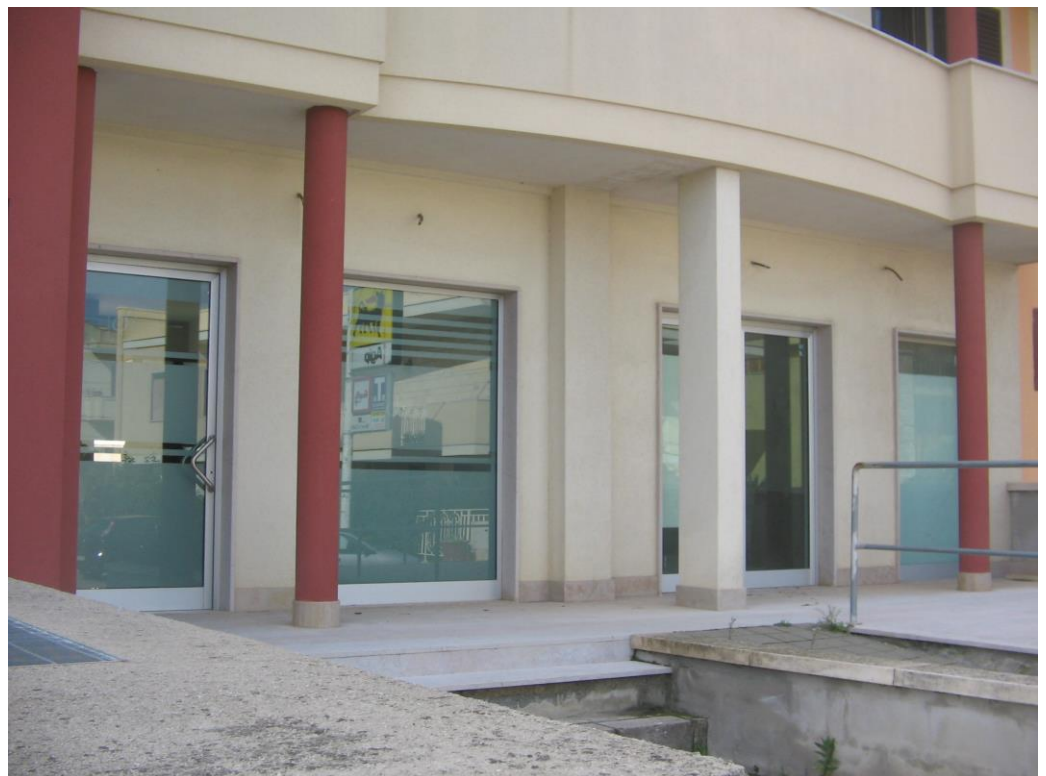
Ingressi locale - prospetto principale
