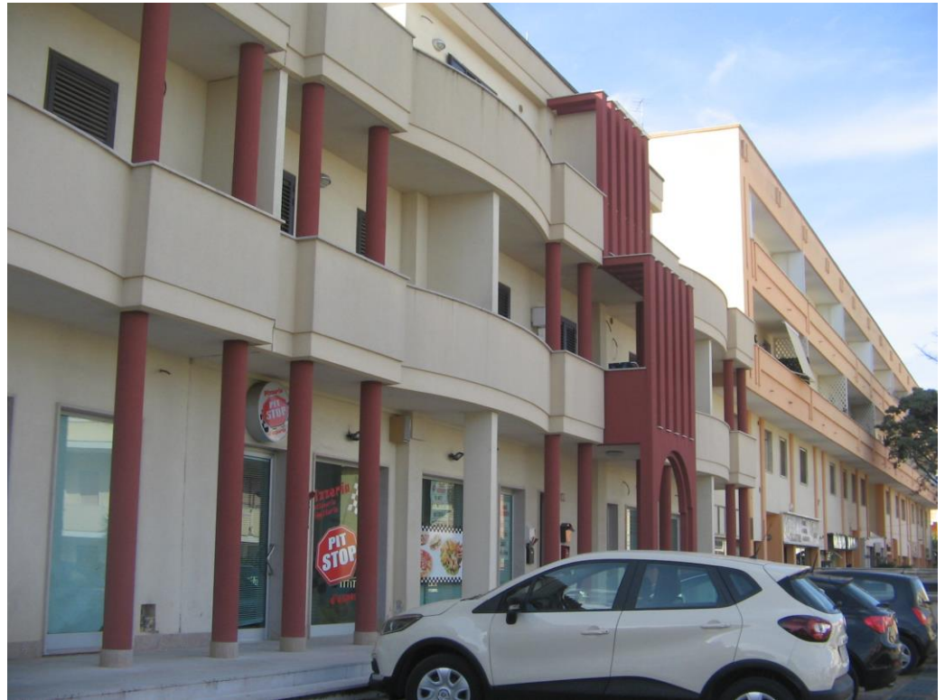
Prospetto edificio su via Provinciale Matino
