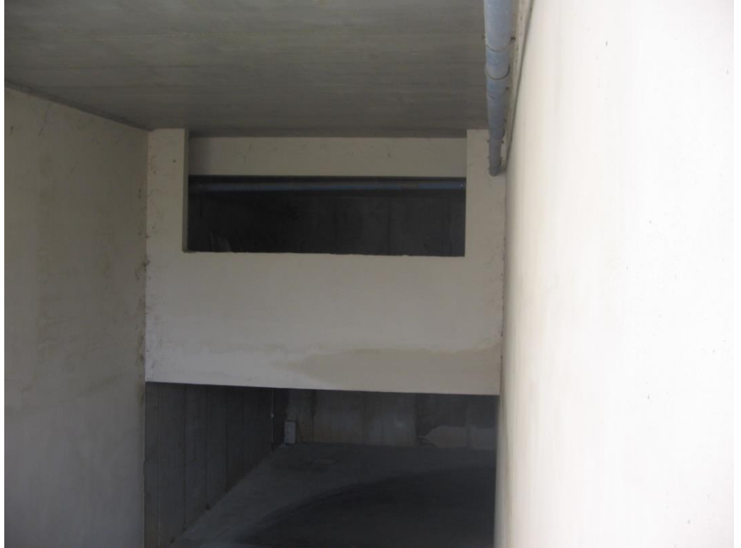
Apertura sottolocale su scivolo al piano interrato 2
