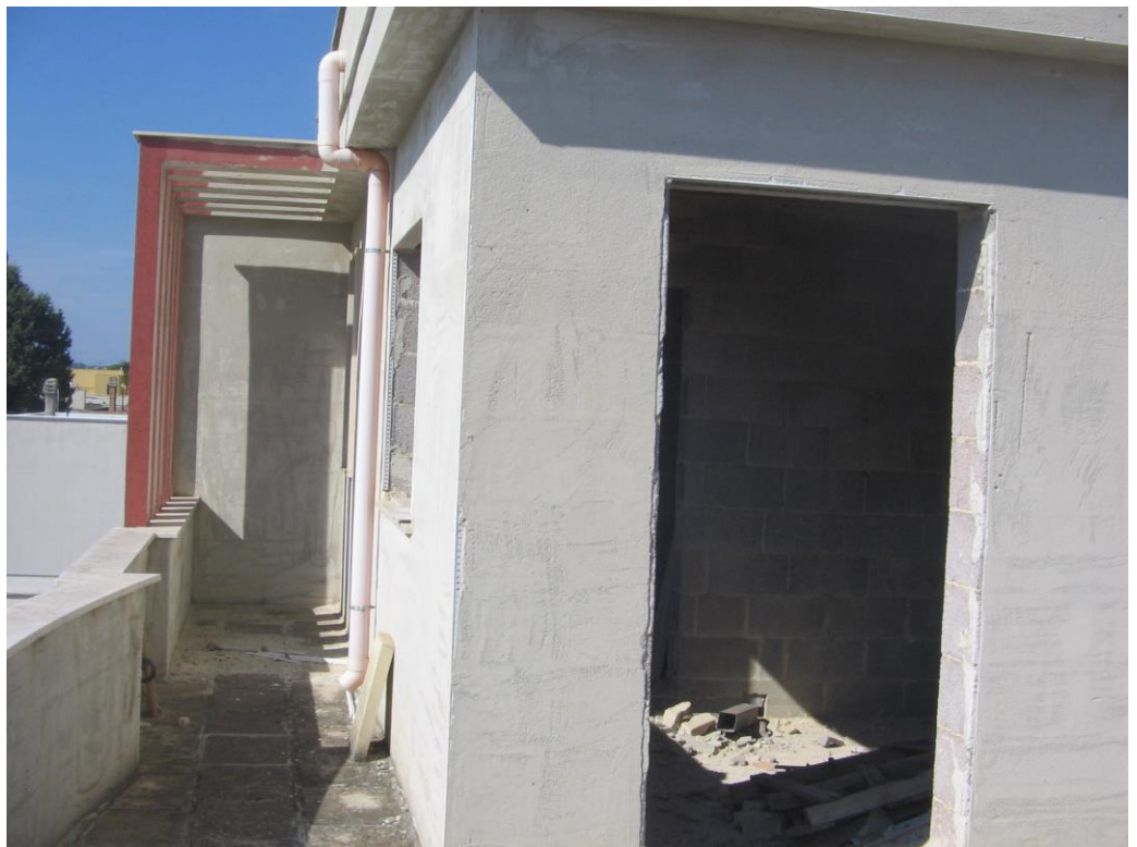
Vano tecnico – piano secondo
