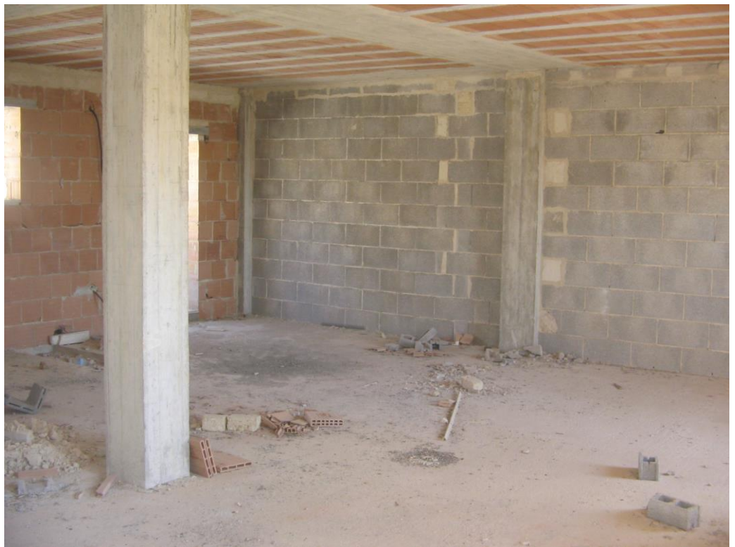
Abitazione senza tramezzature – piano primo
