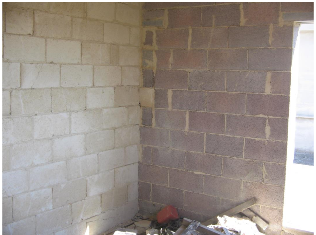
Vano tecnico – piano secondo
