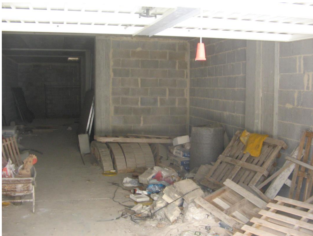
Box (sub. 45) indiviso con cantina piano interrato 1
