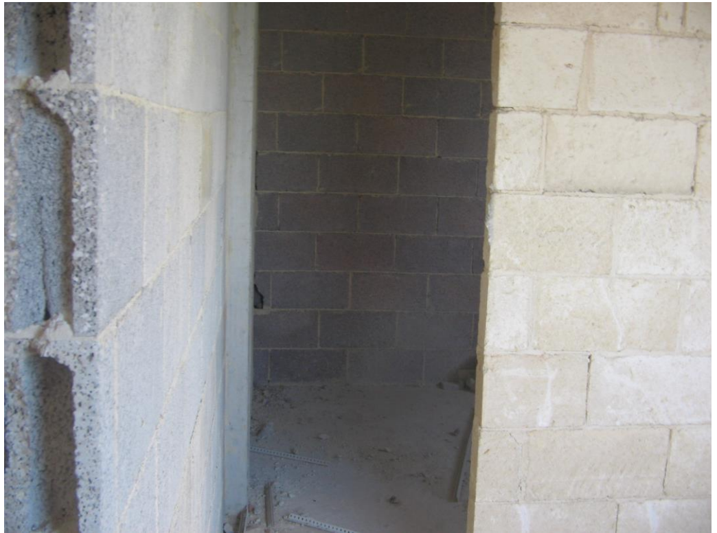
Vano tecnico – piano secondo
