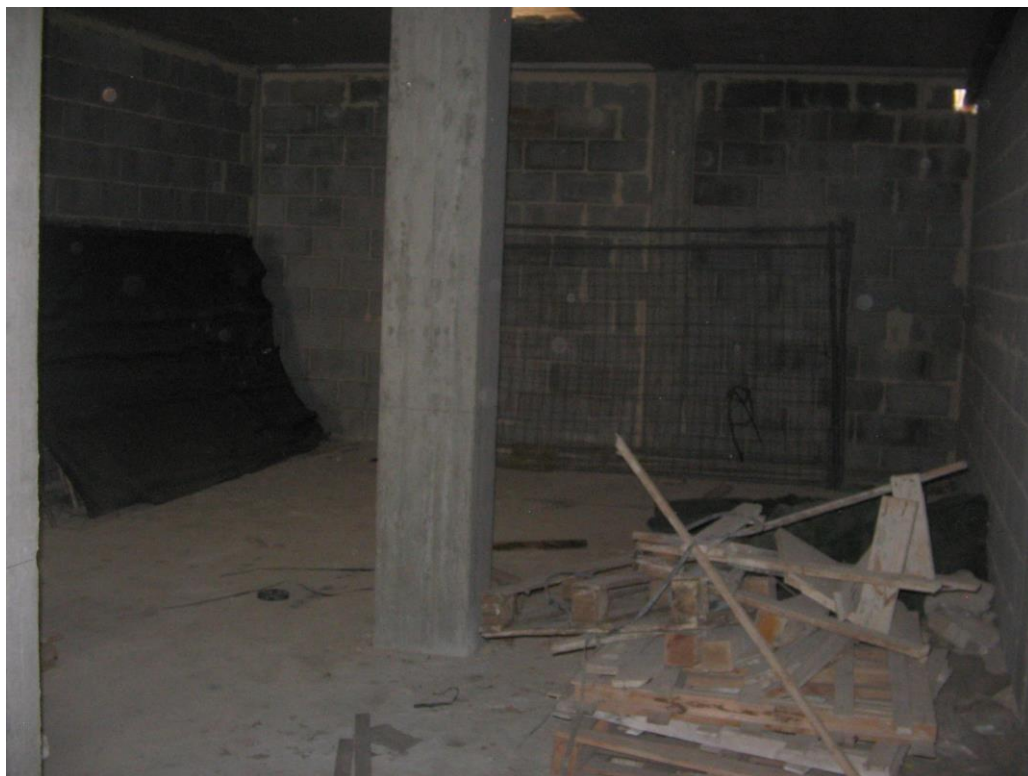
Cantina piano interrato 1
