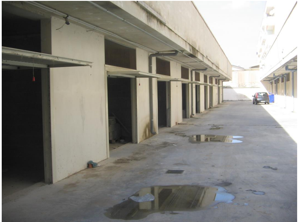
Corsia di manovra piano interrato 1
