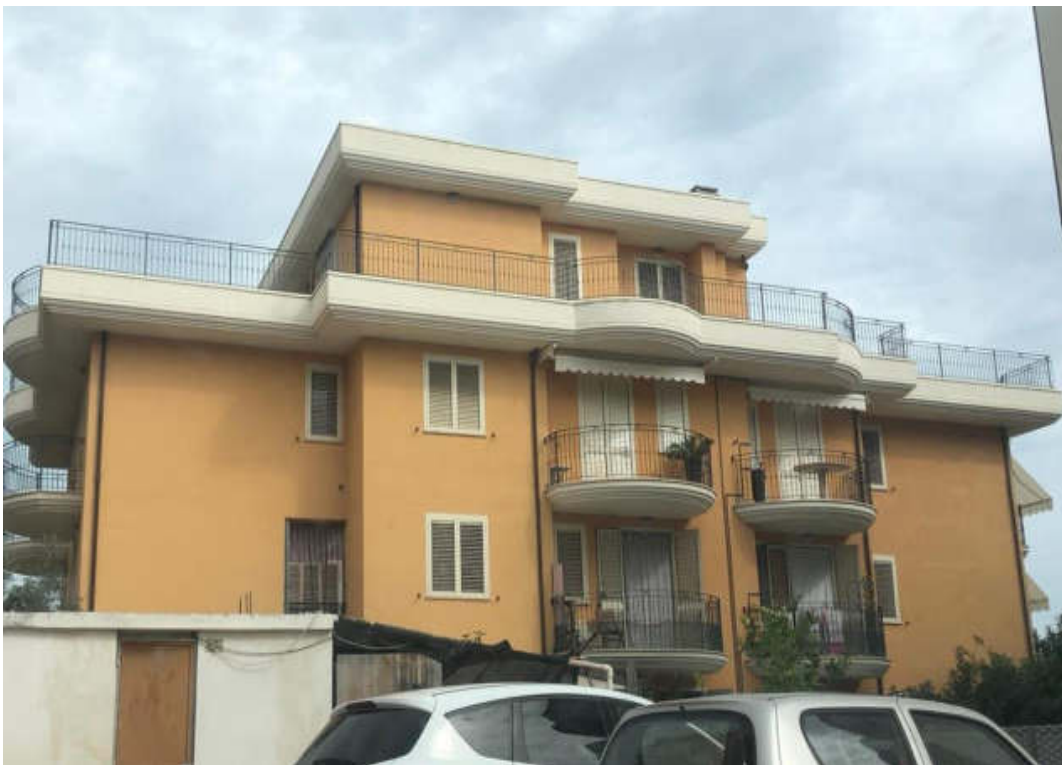
Foto 2: Vista esterna palazzina
