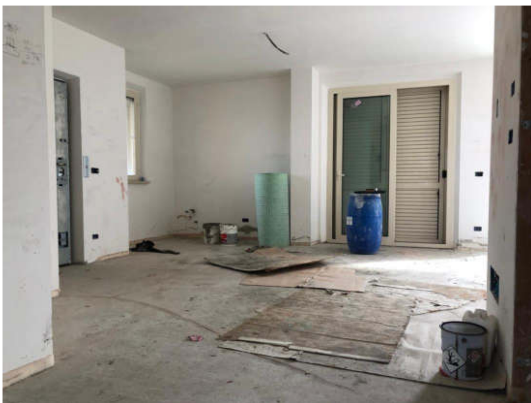
Foto 6: Vista locale pranzo-soggiorno al piano terzo
