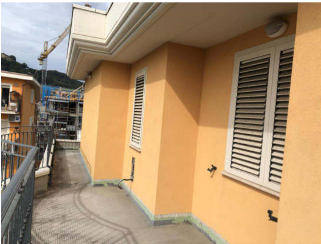
Foto 12: Vista esterna terrazzo al piano terzo
