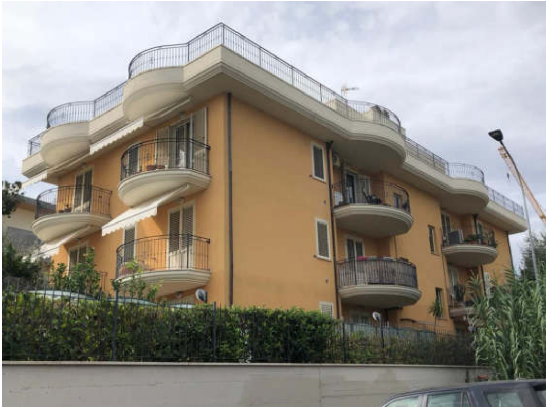
Foto 1: Vista esterna palazzina
