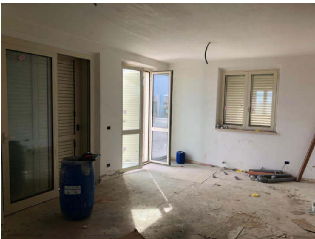
Foto 8: Vista locale pranzo-soggiorno al piano terzo
