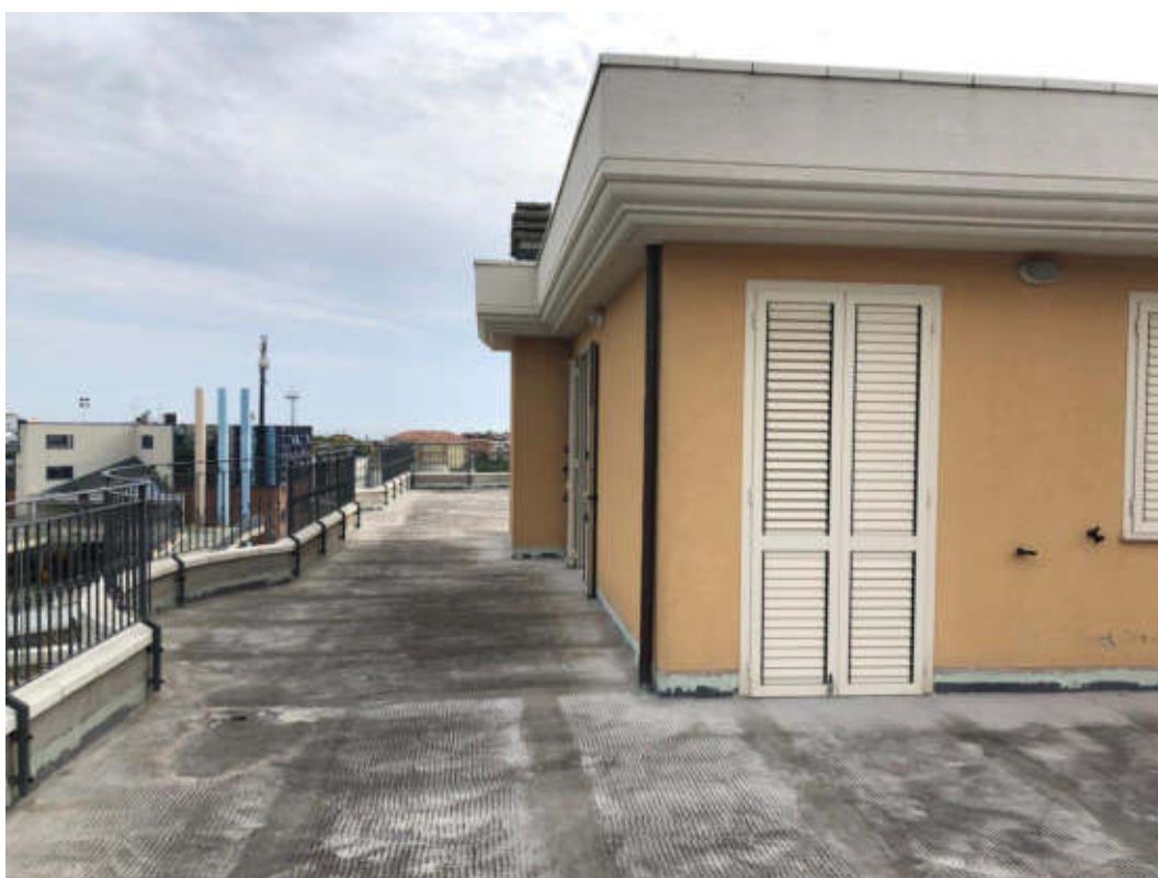
Foto 14: Vista esterna terrazzo al piano terzo
