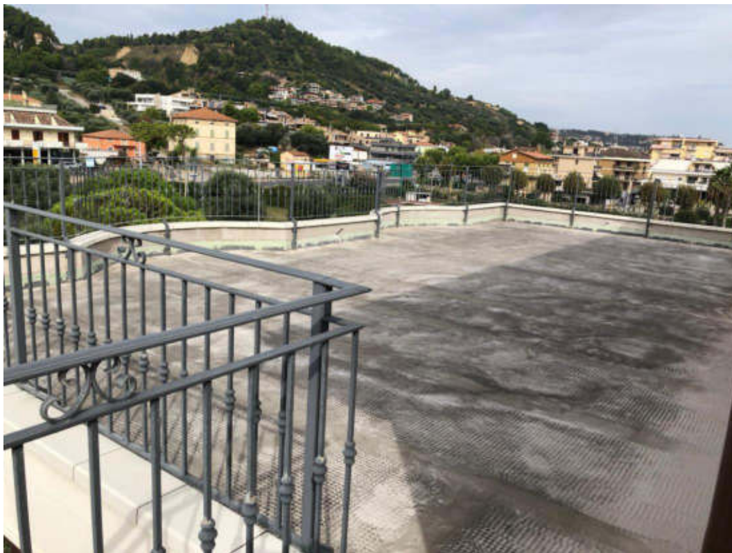
Foto 13: Vista esterna terrazzo al piano terzo
