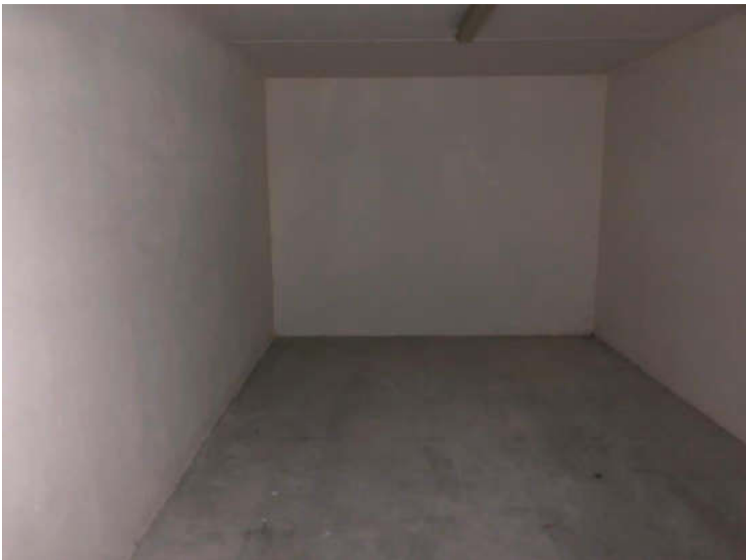
Foto 16: Vista garage al piano interrato
