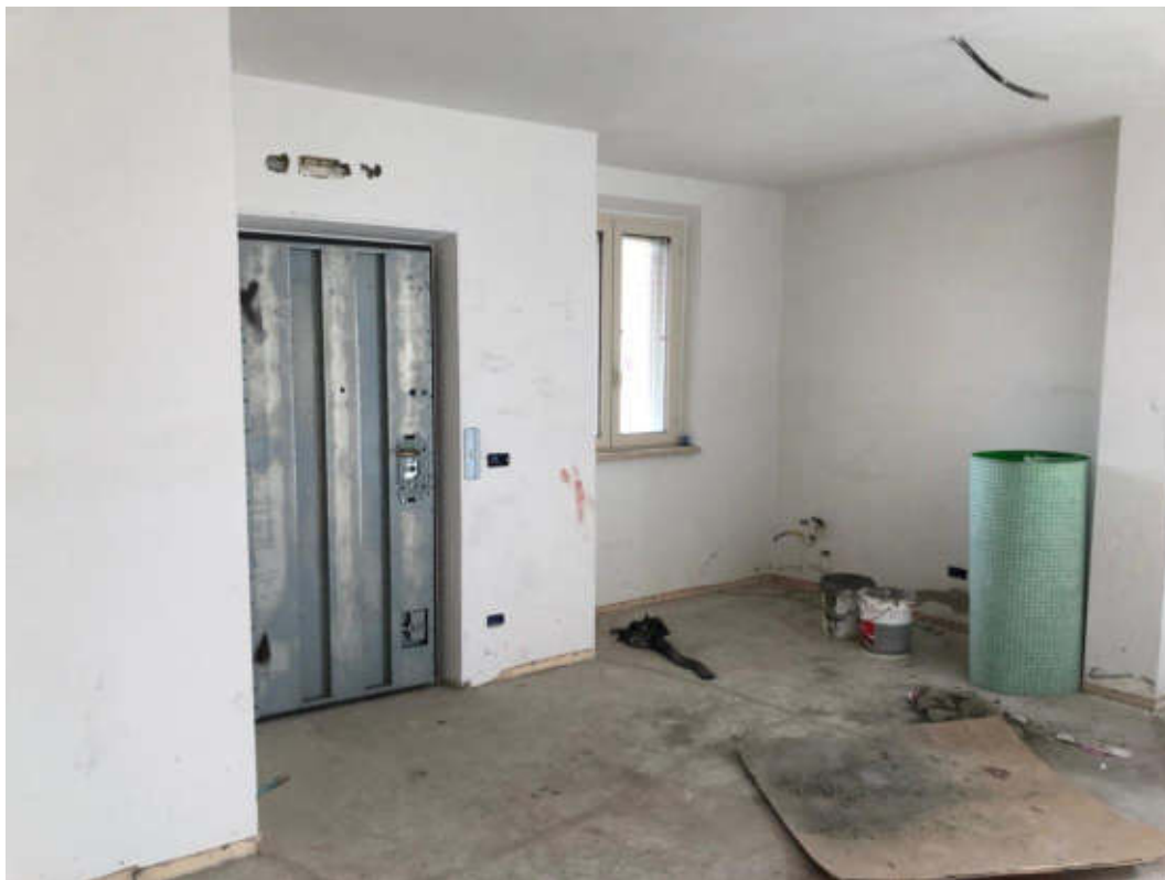
Foto 7: Vista locale pranzo-soggiorno al piano terzo
