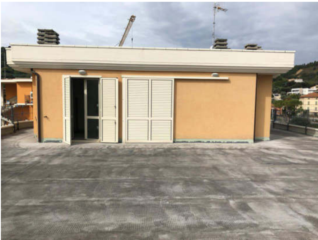
Foto 11: Vista esterna terrazzo al piano terzo
