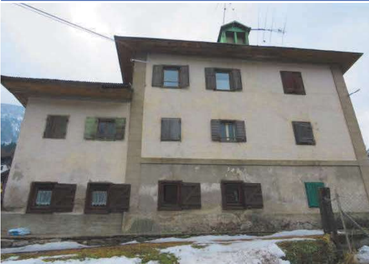
Viste esterne del sub. 1
