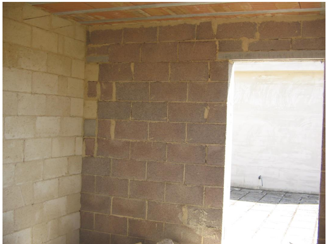
Vano tecnico – piano secondo
