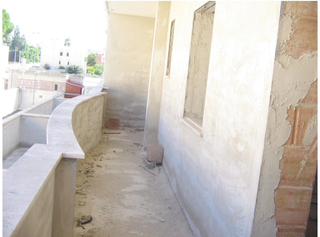
Balcone retrostante – piano primo
