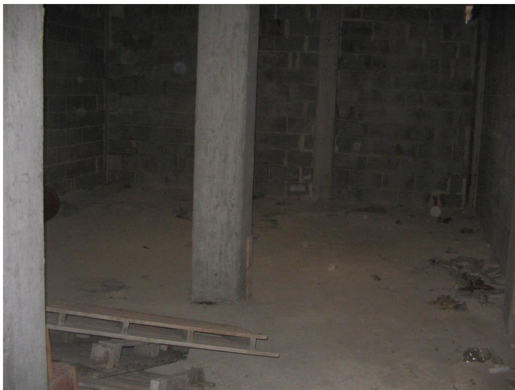
Cantina piano interrato 1
