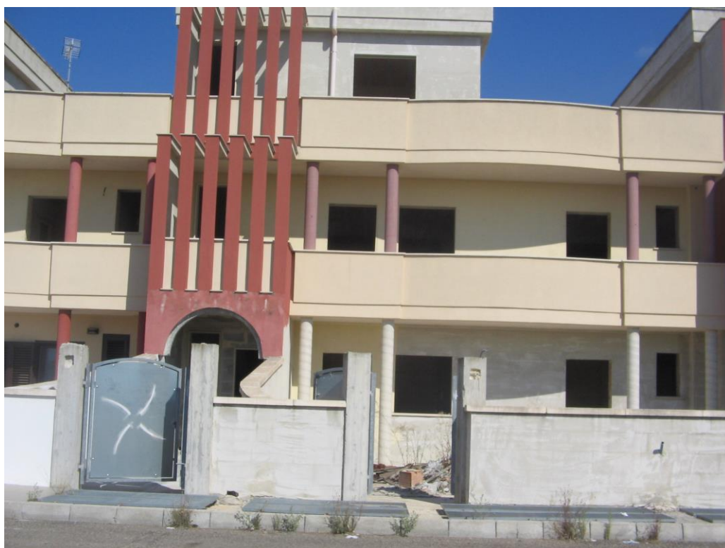
Prospetto ingresso-vano scala dell'abitazione al piano primo
