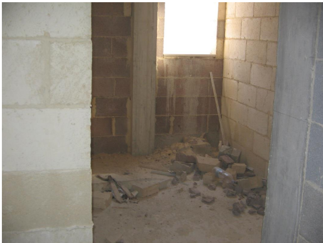
Vano tecnico – piano secondo
