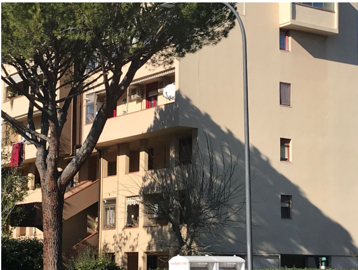
Particolare dell'edificio. La scala di accesso al ballatoio dal quale si accede all'appartamento
