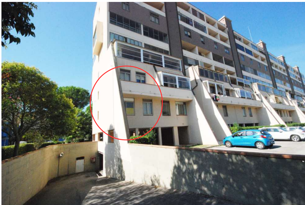
Il retro dell'edificio con indicato, nel cerchio rosso, l'appartamento
