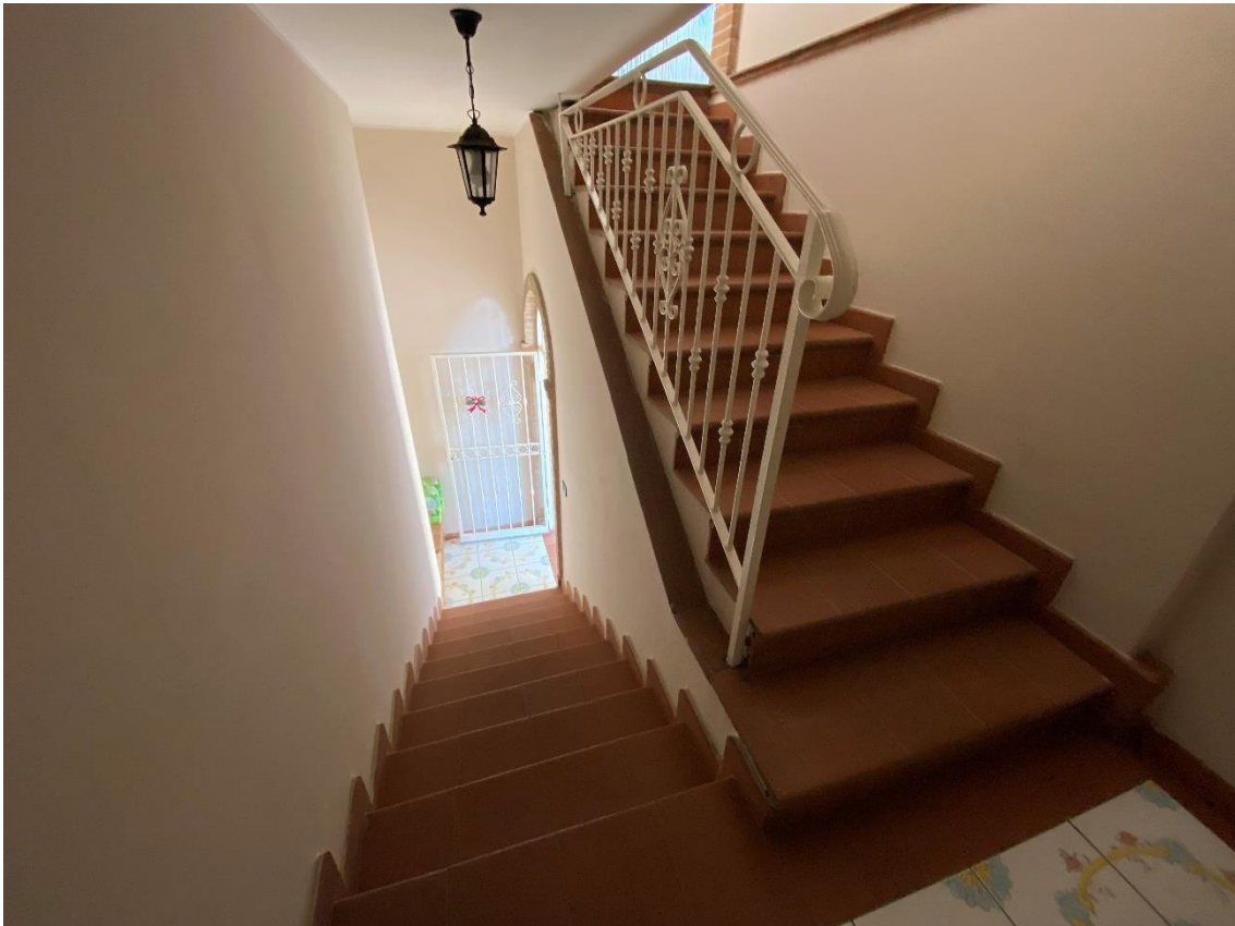
Ingresso scala per accesso piano primo sub. 4 - lotto 2-
