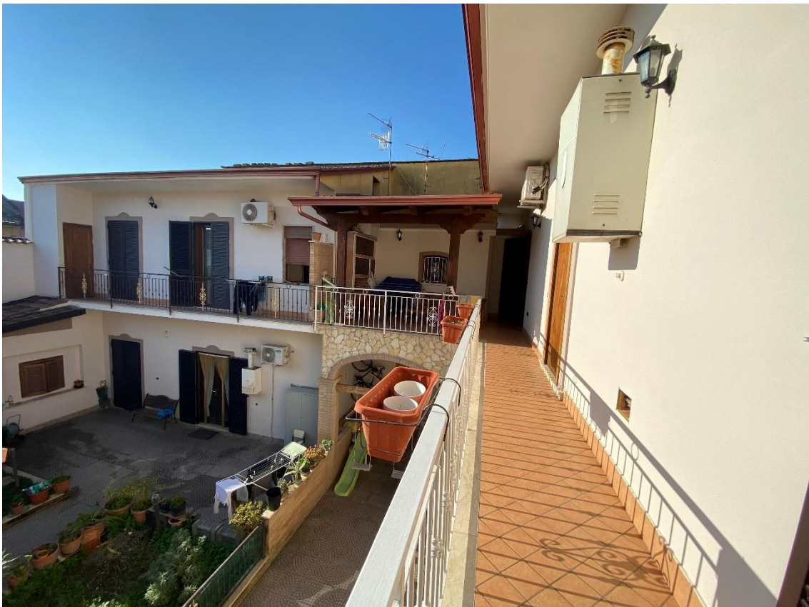
Balcone 2/ terrazzo piano primo sub. 4 lotto 2
