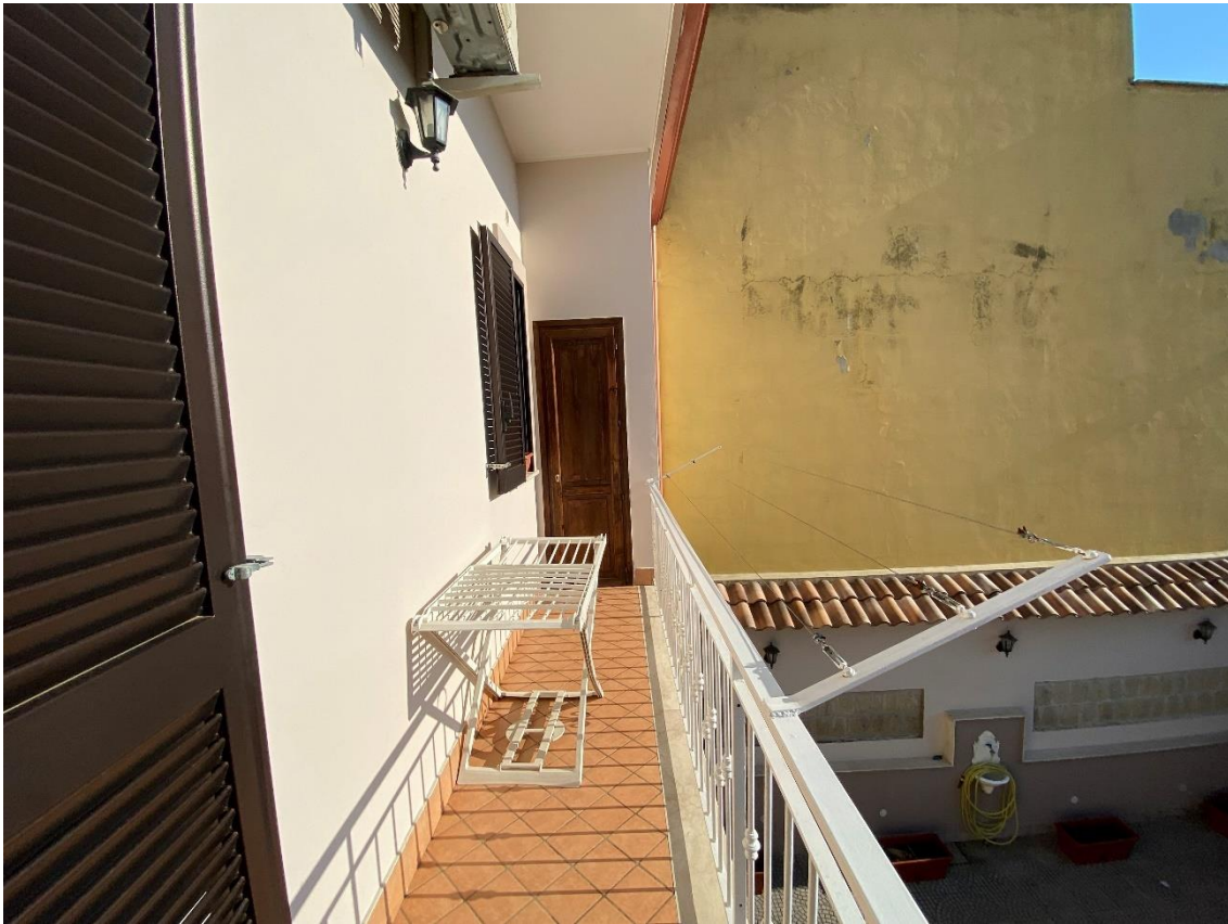
Balcone 2/terrazzo piano primo sub. 4 - lotto 2-
