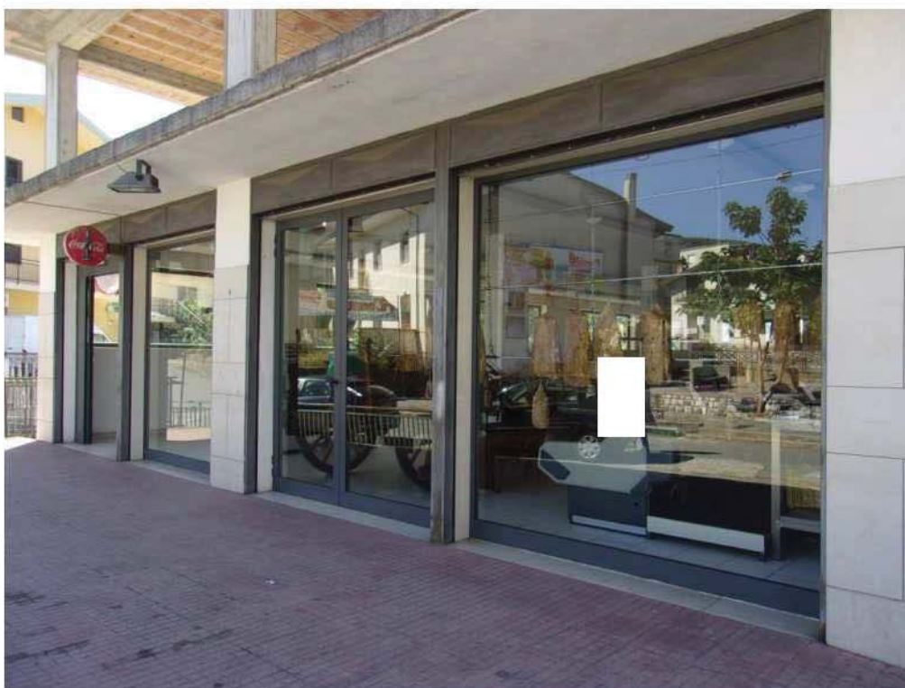
Foto 24. Facciata lato est fronte strada via San Marco.
