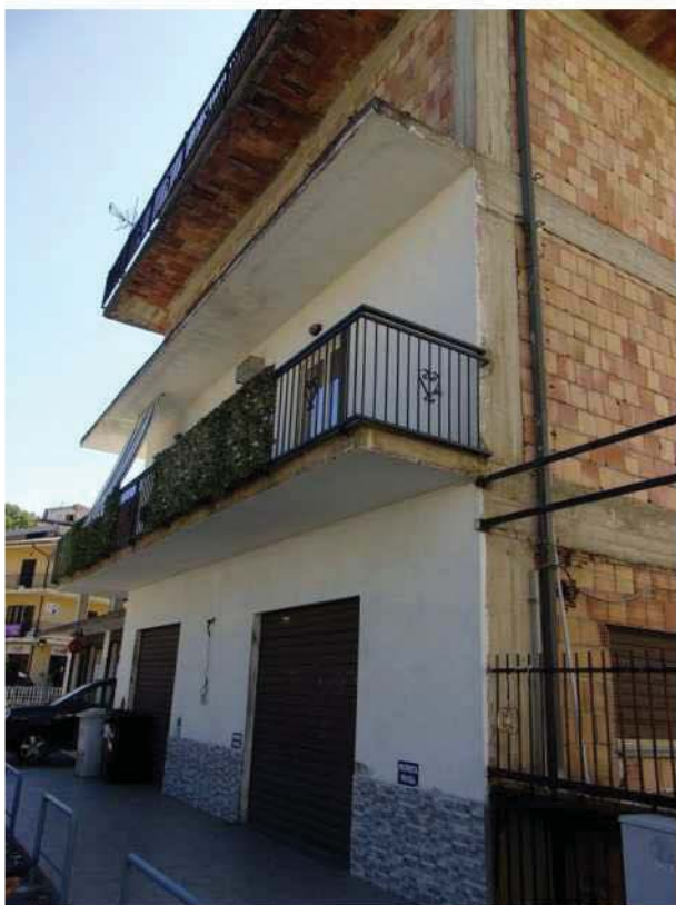
Foto 9. Facciata su Via San Marco
