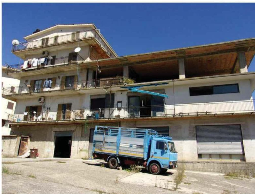
Foto 5. Lato ovest, il retro dell'edificio in oggetto e parte del piazzale.
