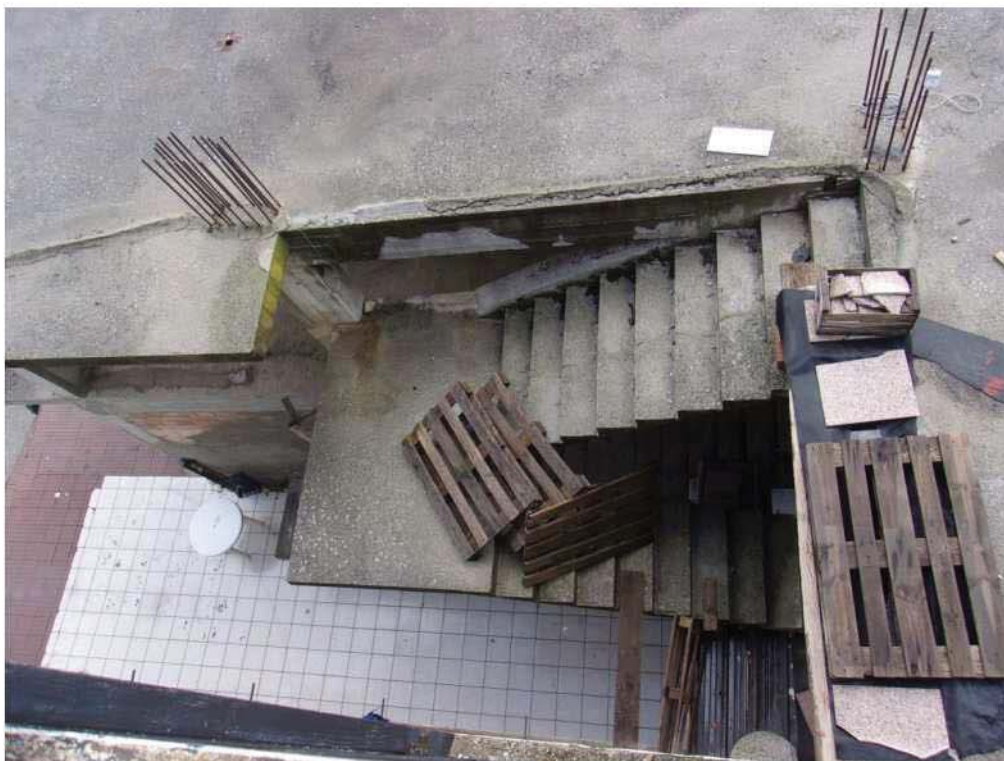
Foto 35. Scala di accesso
