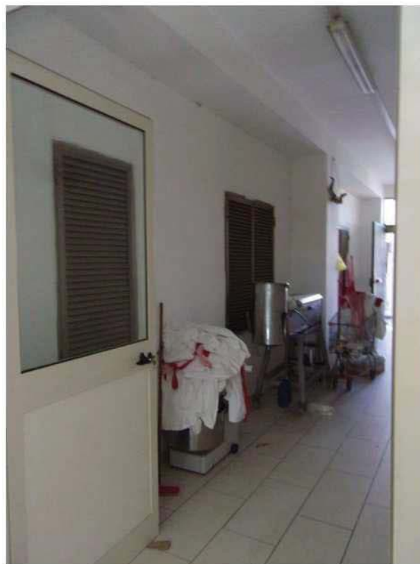
Foto 29. Particolare degli affacci delle finestre dell'appartamento sub 14 nel corridoio interno al magazzino.
