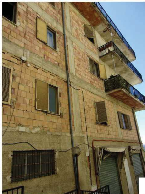
Foto 8. Lato nord prospetto fabbricato.
