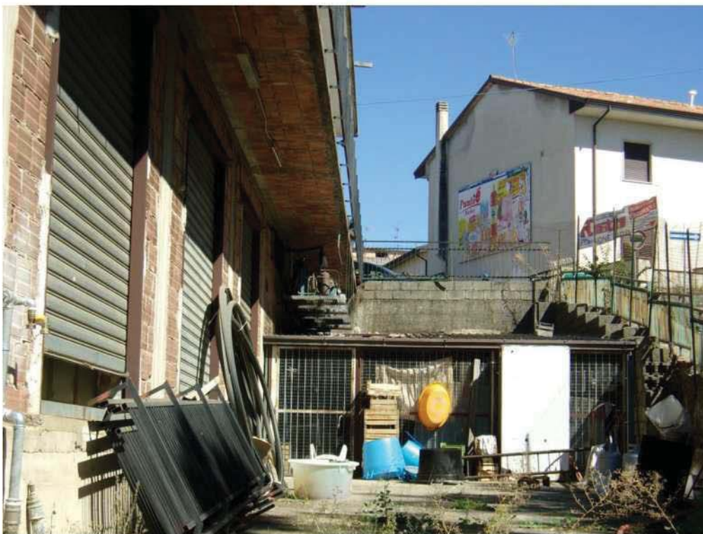
Foto 17. Particolare lato sud sub 13.
