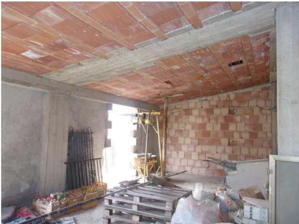
Foto 96-97-98. Particolari dell'immobile allo stato rustico
