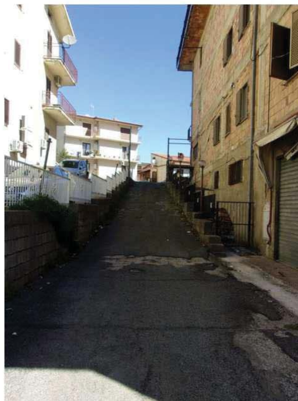
Foto 22. Rampa di accesso al sub 13 lato nord.
