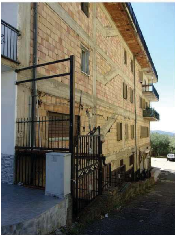
Foto 7. Lato nord ingresso piazzale.
