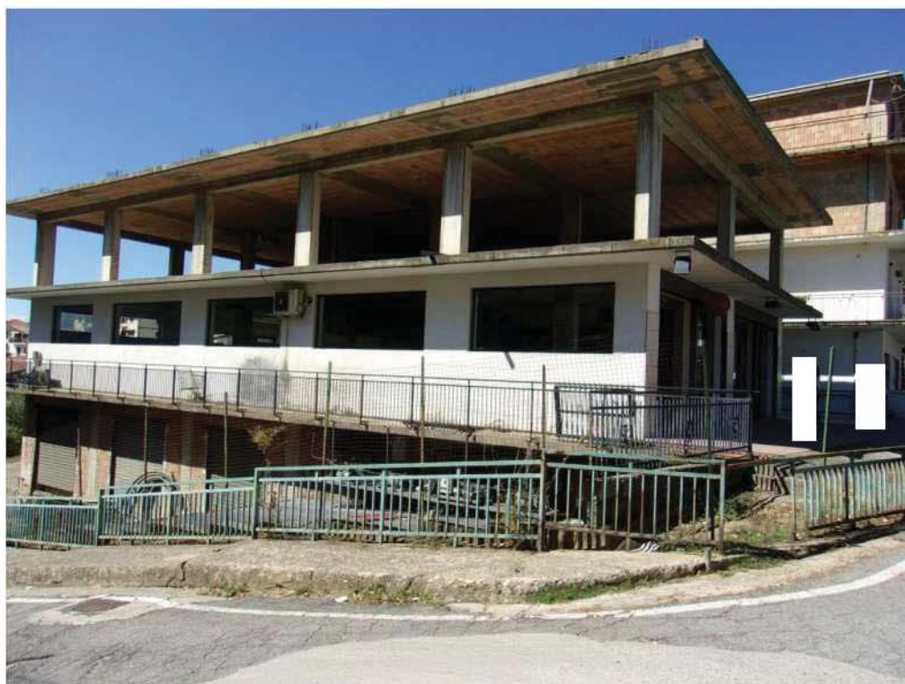
Foto 6. Lato sud Via Cesare Curcio .
