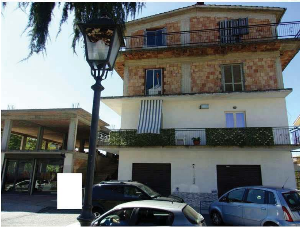
Foto 3. Particolare del fabbricato quota nord.
