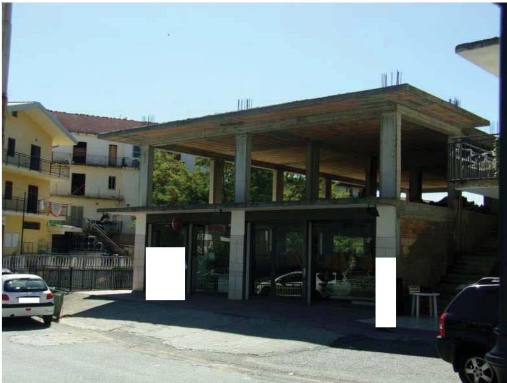
Foto 4. Lato est particolare del fabbricato quota sud.
