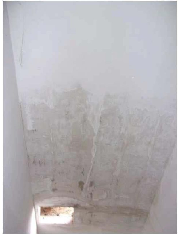
Foto 41. Particolare del sottotetto al terzo piano
