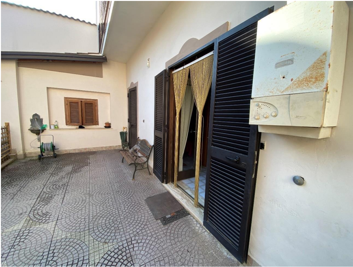
Ingresso piano terra sub. 5 e sub. 6 - lotto 3-
