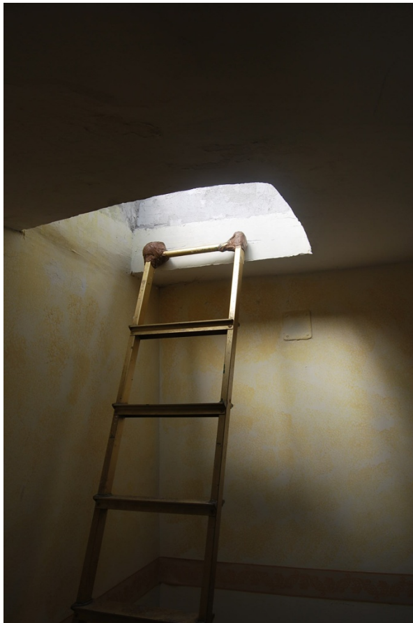
FOTO 9 PARTICOLARE BOTOLA SOPPALCO U. IMMOBILIARE PORZIONE 1
