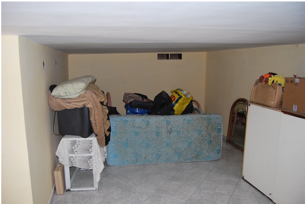
FOTO 14 PARTICOLARE SOPPALCO CUC./SOGG. U. IMMOBILIARE PORZIONE 2
