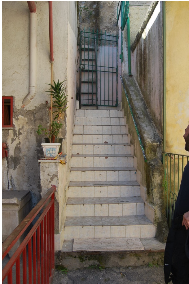
FOTO 1 – SCALA DI ACCESSO ALL' UNITA' IMMOBILIARE
