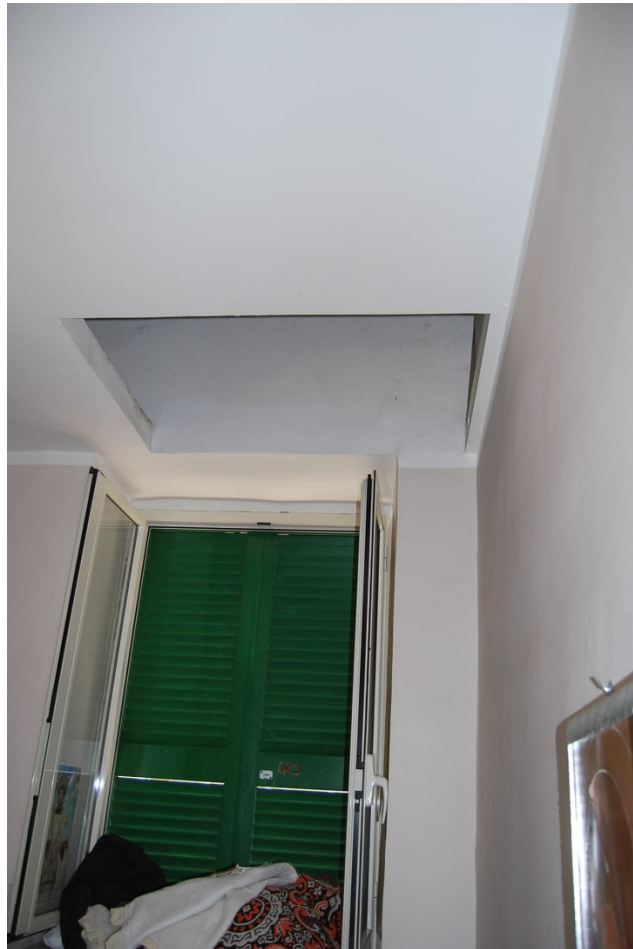
FOTO 16 PARTICOLARE BOTOLA SOPP./DEP. LETTO U. IMMOBILIARE PORZIONE 2
