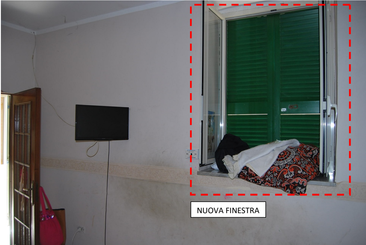
FOTO 15 PARTICOLARE NUOVA FINESTRA LETTO U. IMMOBILIARE PORZIONE 2
