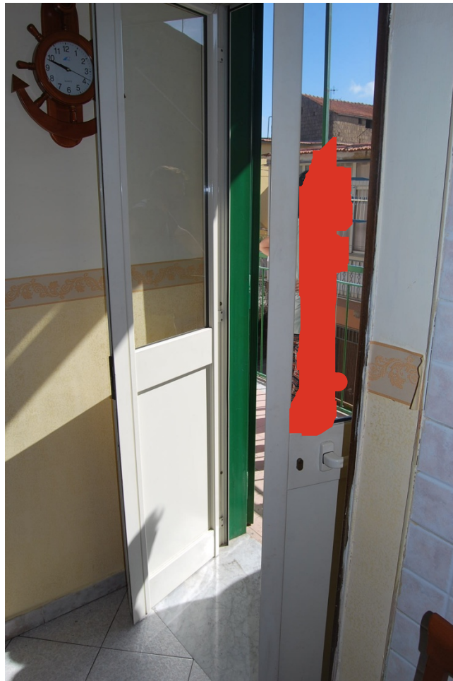
FOTO 5 – PARTICOLARE INGRESSO U. IMMOBILIARE PORZIONE 1
