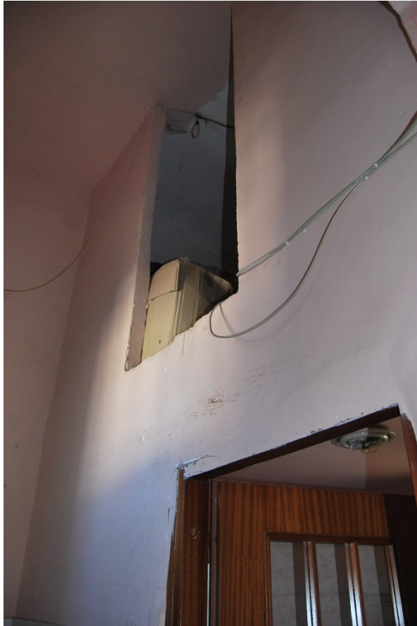
FOTO 13 PARTICOLARE SOPPALCO BAGNO U. IMMOBILIARE PORZIONE 2
