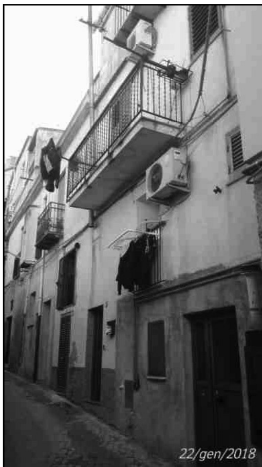
Foto n. 19 –Visione dell'unità immobiliare prospiciente la via Grappa
