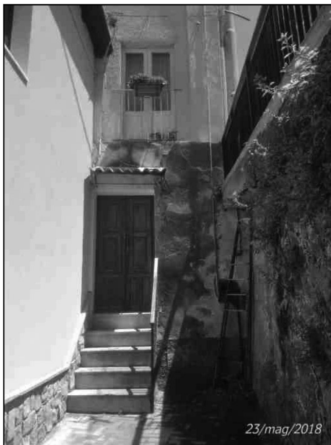
Foto n. 17 – Ingresso dell'unità immobiliare dalla via Galileo Galilei
