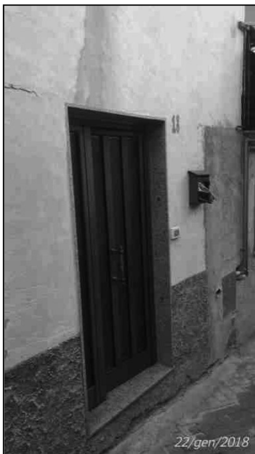
Foto n. 20 – Ingresso dell'unità immobiliare dalla via Galileo Galilei
