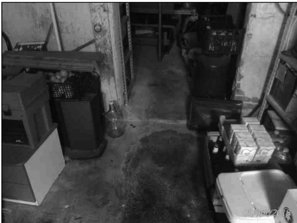
Foto n. 6 – Pavimento dell'unità immobiliare
