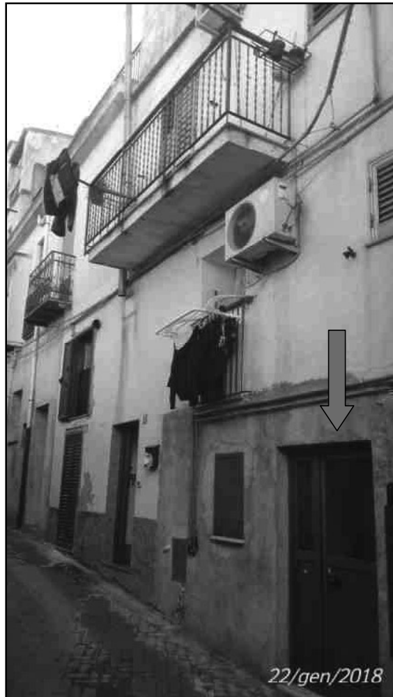
Foto n. 5 – Ingresso all'unità immobiliare identificata con la particella 522 sub. 7
