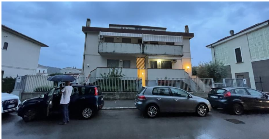
Foto n. 2 - Fabbricato lato Nord
