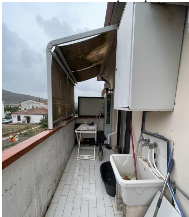
Foto n. 12 - Terrazza piano primo
