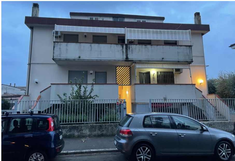
Foto n. 3 - Fabbricato lato Nord
