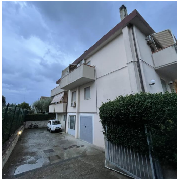
Foto n. 4 - Fabbricato lato Est
