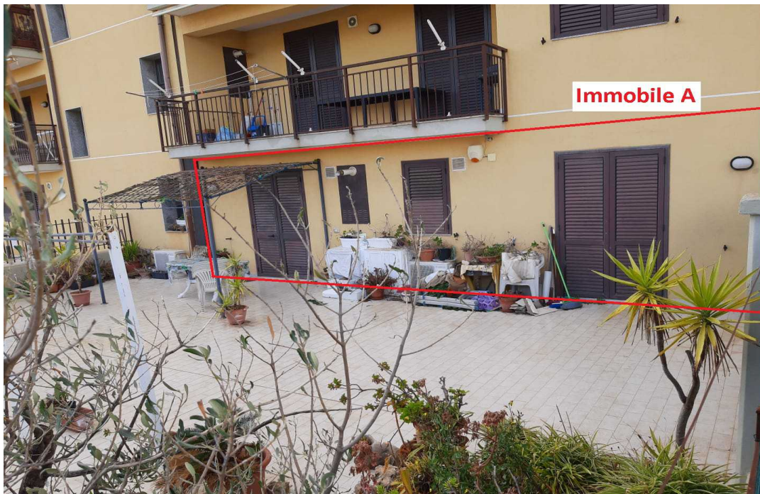
G.01A – Esterno lato Est - edificio in cui è ubicato al piano terra l'Immobile A.
