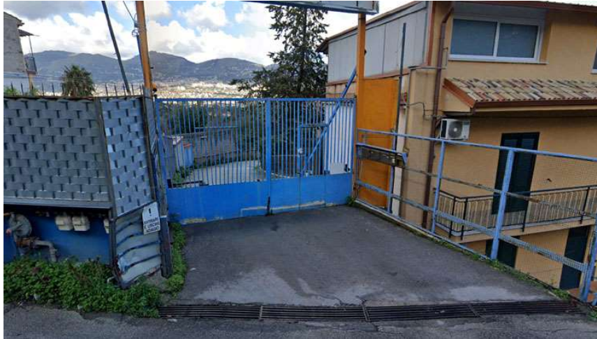
Foto 1. Cancelli di ingresso da via Ciraulo n. 25 al complesso immobiliare e al fabbricato di cui fa parte il bene pignorato
