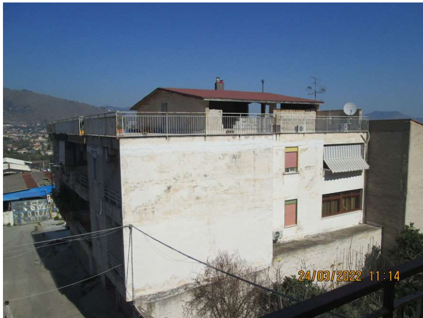
Foto 6. Fronte sud-est del fabbricato di cui fa parte il bene pignorato
