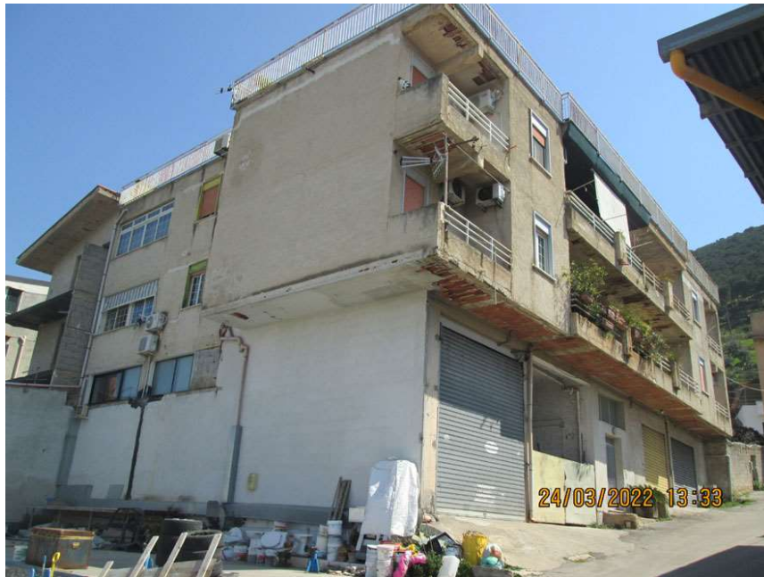
Foto 5. Fronte nord ovest e fronte principale sud-ovest del fabbricato di cui fa parte il bene pignorato
