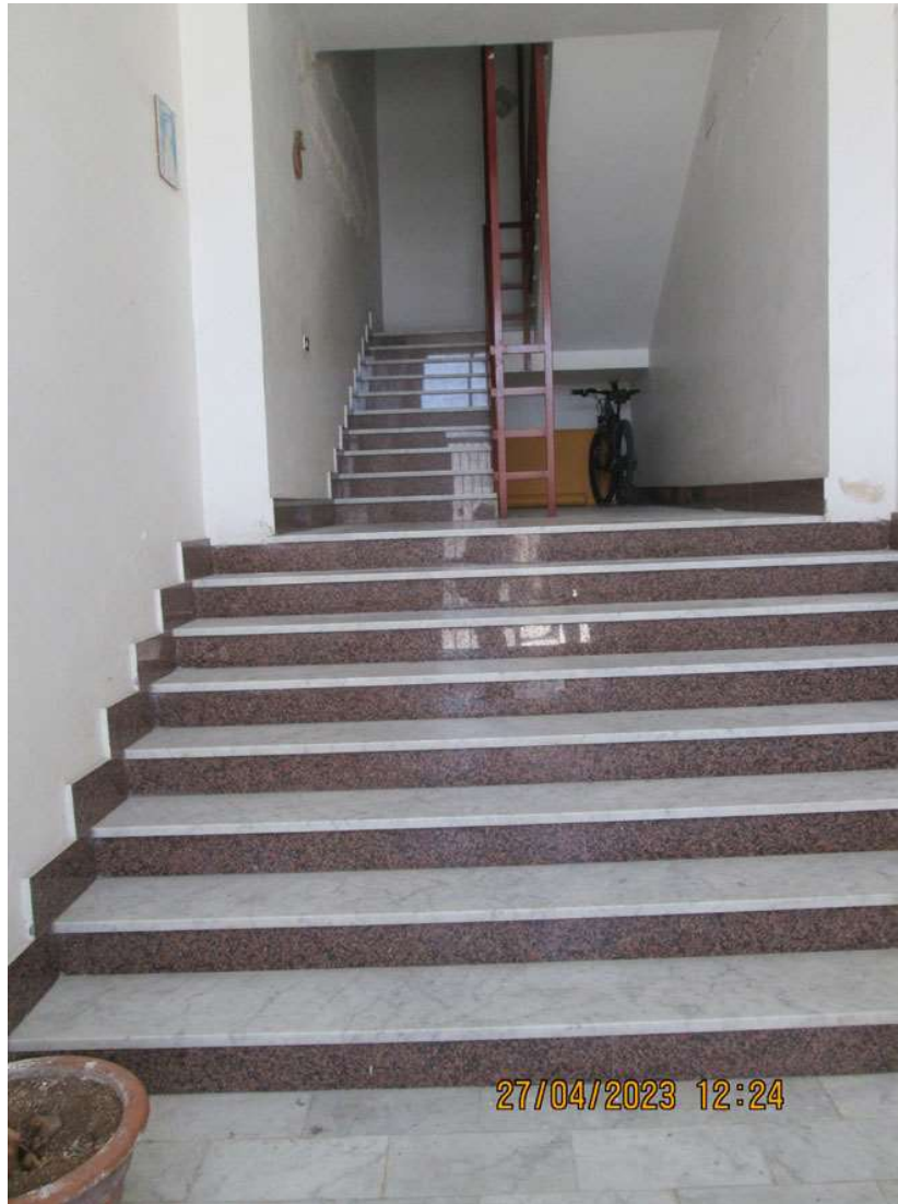
Foto 8. Androne e scala condominiale del fabbricato di cui fa parte il bene pignorato
