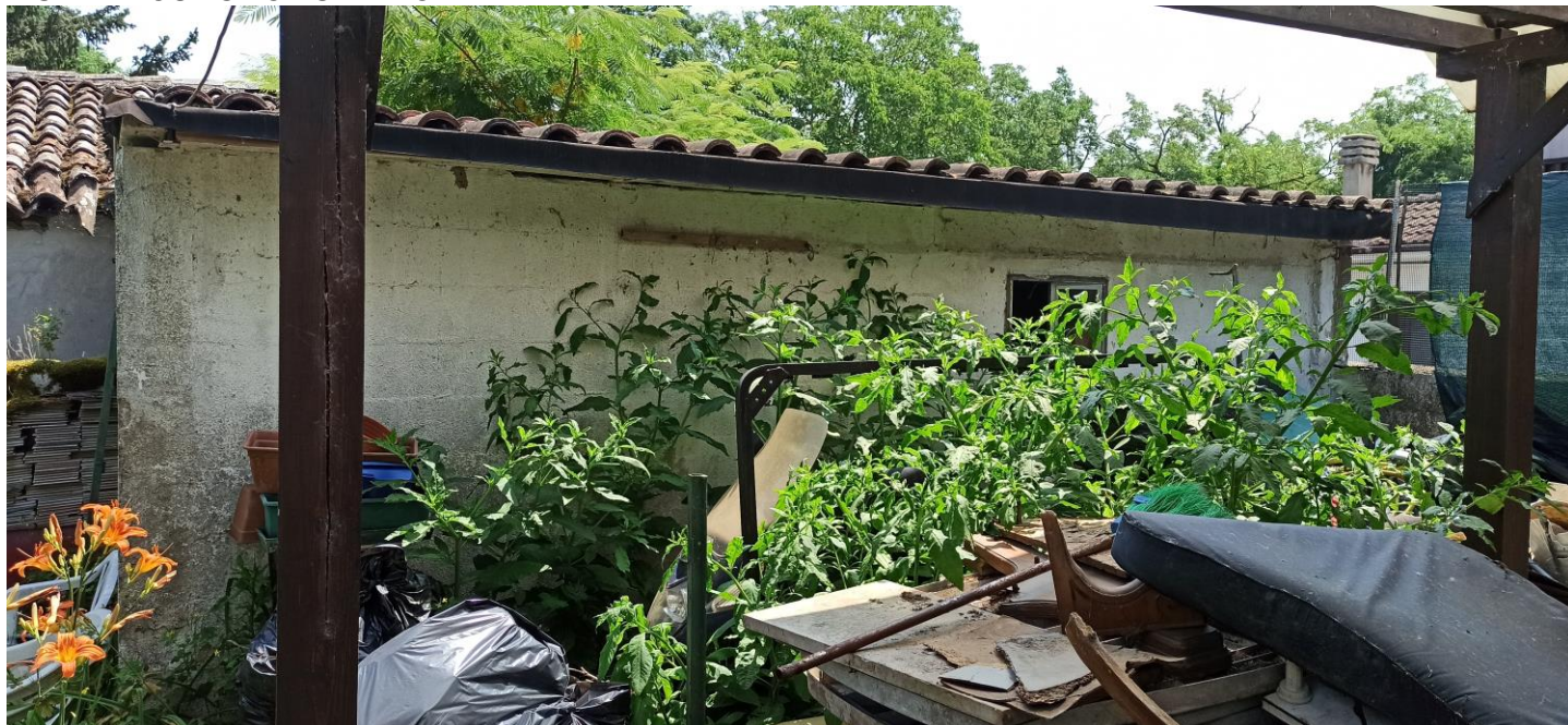
VISTA RIPOSTIGLIO ESTERNO
