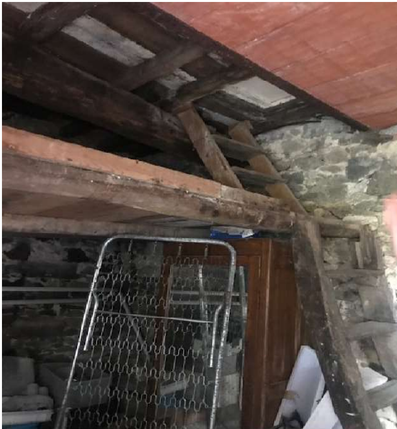
scala di collegamento al piano terra
