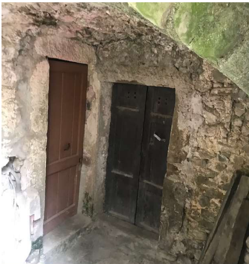
Sulla dx l'accesso alla cantina al piano seminterrato
