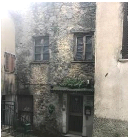
prospetto su via dell' aia lato ingresso
