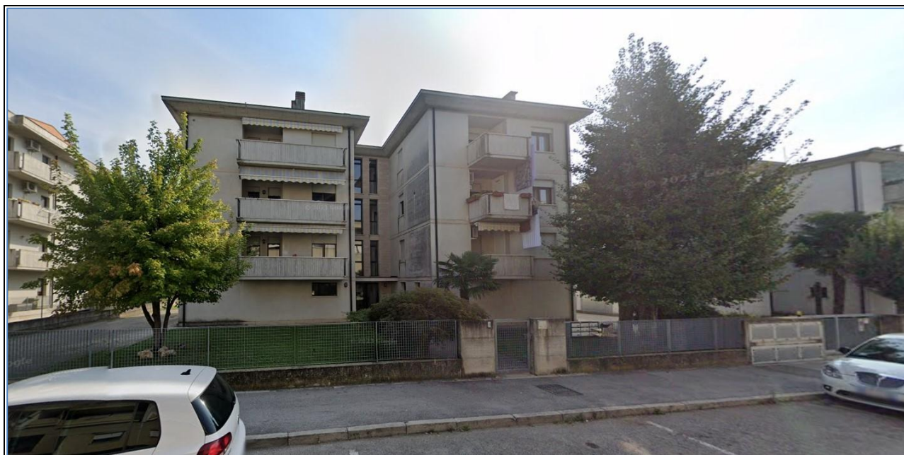
Ingresso pedonale da viale Giovanni Carli n° 9 (prospetto ovest) – Condominio “GIADA”
