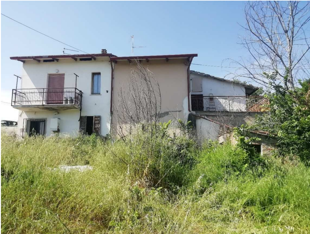
Foto 2 - Prospetto laterale, intero fabbricato e resede sub.1
