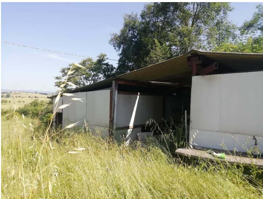
Foto 6 – Vista annesso precario sul resede a comune sub.1
