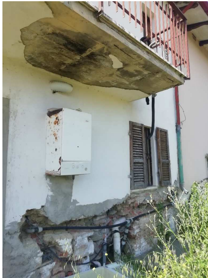
Foto 8 – passaggio tubazioni impianti sul prospetto N-E
