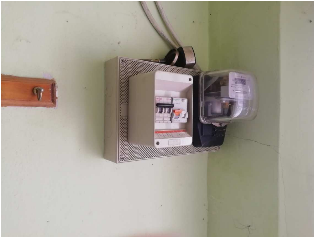
Foto 25 – Interruttore - Contatore
