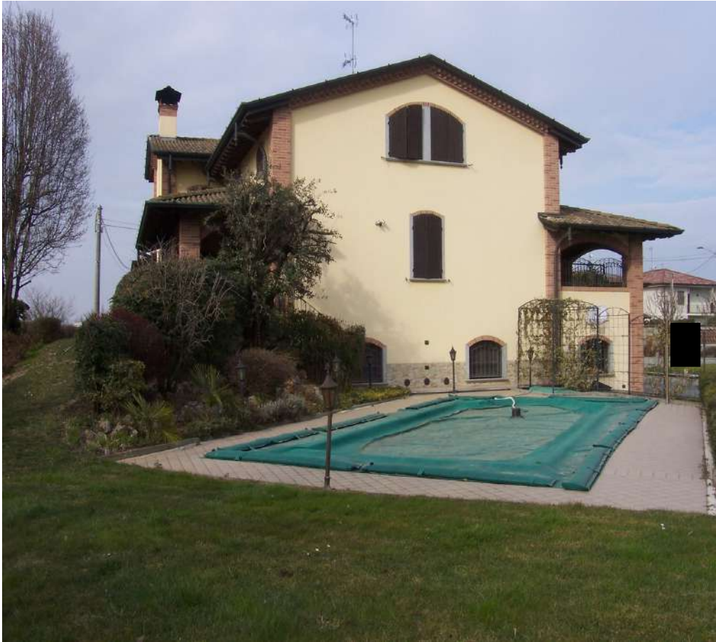
- Vista dal giardino Sud - Ovest - 3
